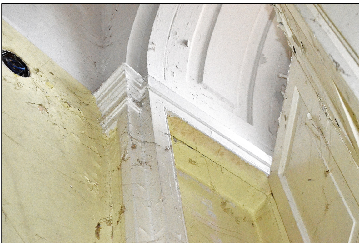
II. 31 Wieniec, Pałac – parter – elewacja południowa - stolarka okienna TYP IVA – okno nr 14 – widok na dekoracyjną skrzynkę okiennicy
