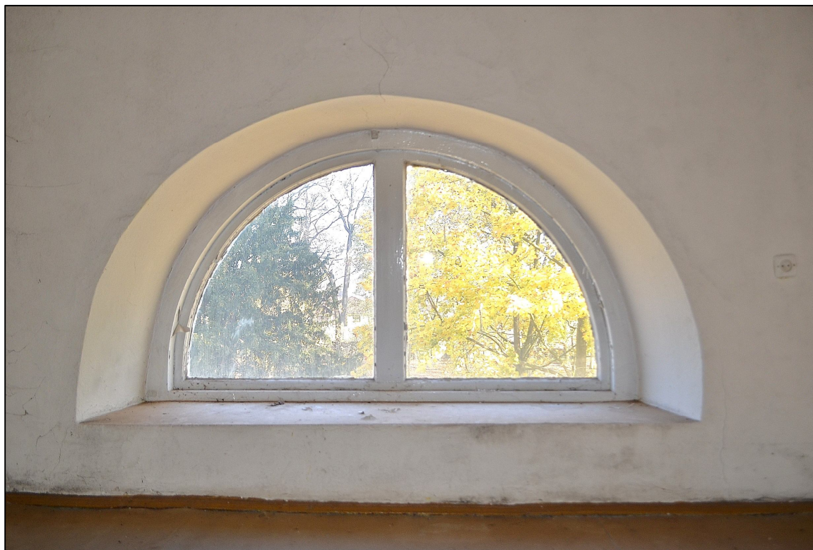
II. 38 Wieniec, Pałac – parter – elewacja wschodnia - stolarka okienna TYP IVB – okno nr 1 – widok na awers nadświetlenia
