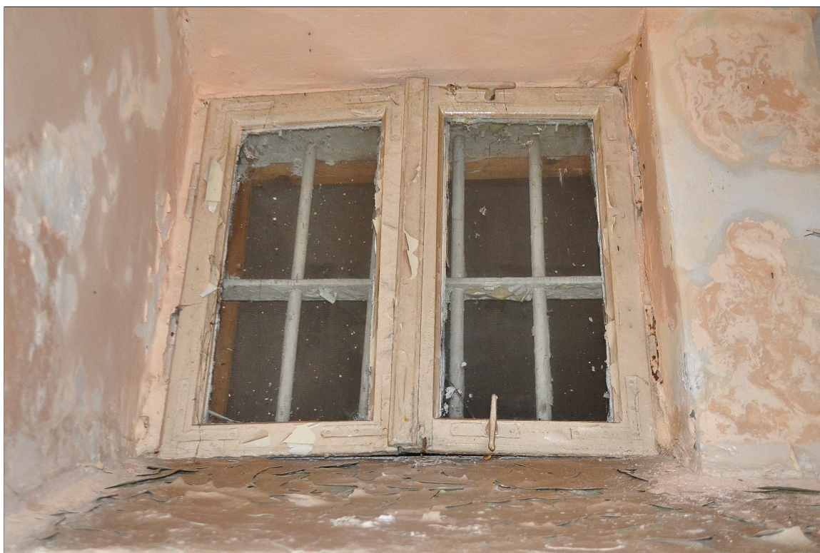
II. 15 Wieniec, Pałac – piwnica – elewacja zachodnia - widok na rewers stolarki okiennej TYP I A - okno nr 3
