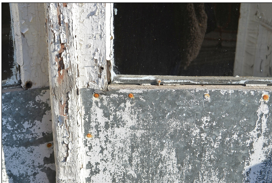
II. 147 Wieniec – Pałac – I piętro - elewacja zachodnia - stolarka drzwiowa TYP A/3 – awers – otwór nr 10 – fragment skrzydła obitego blachą
