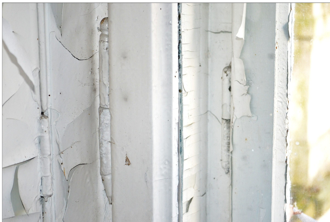
II. 49 Wieniec, Pałac – parter – elewacja południowa
