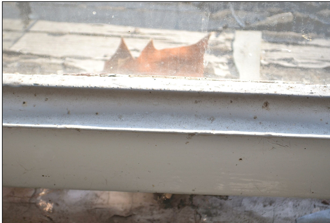
II. 71 Wieniec – Pałac – parter – elewacja południowa
