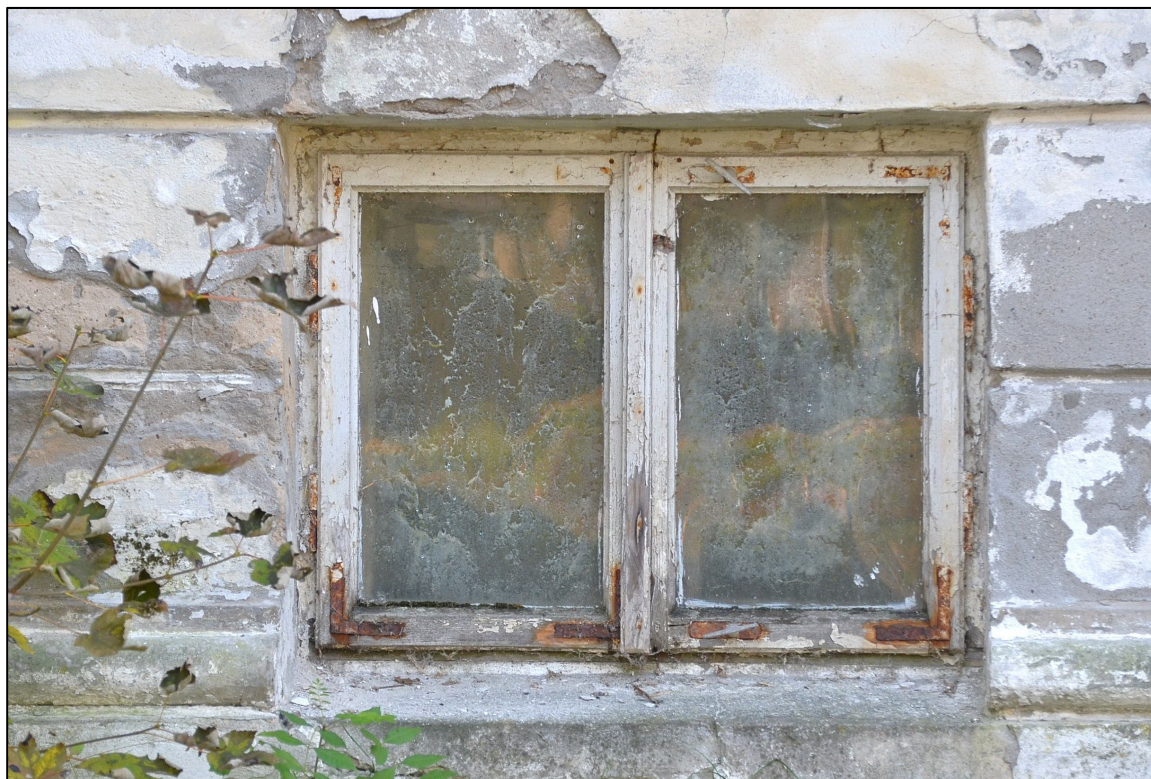
II. 16 Wieniec, Pałac – piwnica – elewacja wschodnia - widok na awers stolarki okiennej TYP I A - okno nr 4
