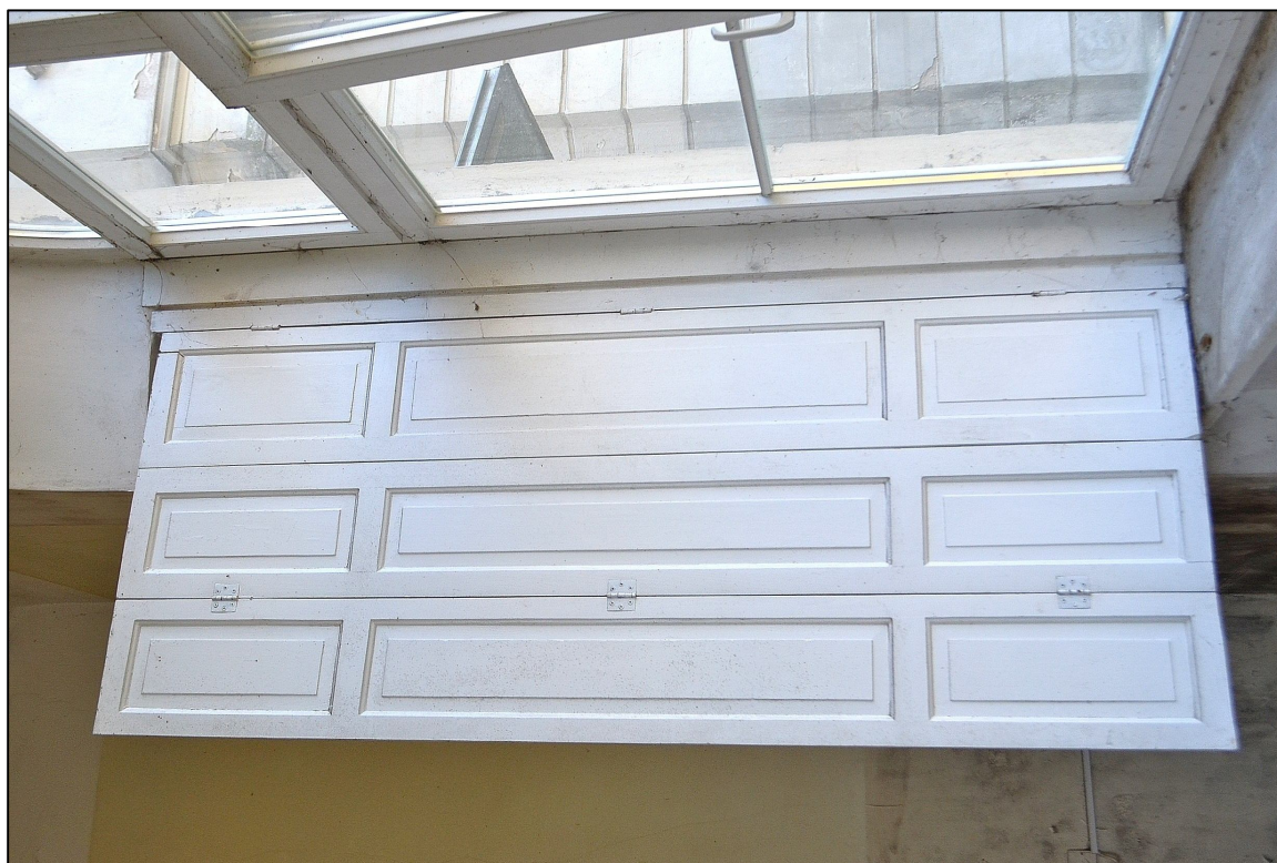
II. 99 Wieniec, Pałac – parter
