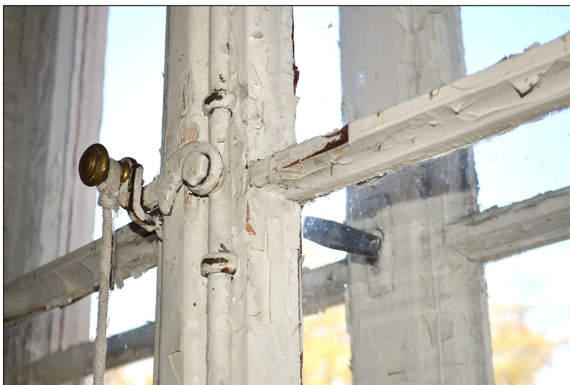
II. 117 Wieniec, Pałac – I piętro
