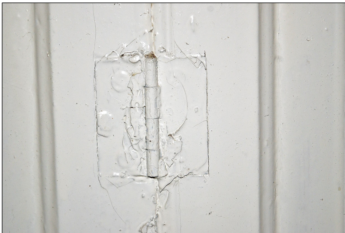
II. 97 Wieniec, Pałac – parter - pierwotna okiennica okienna – widok na pierwotny zawias czopowy spletany łączący poszczególne części skrzydła łamanego okiennicy
