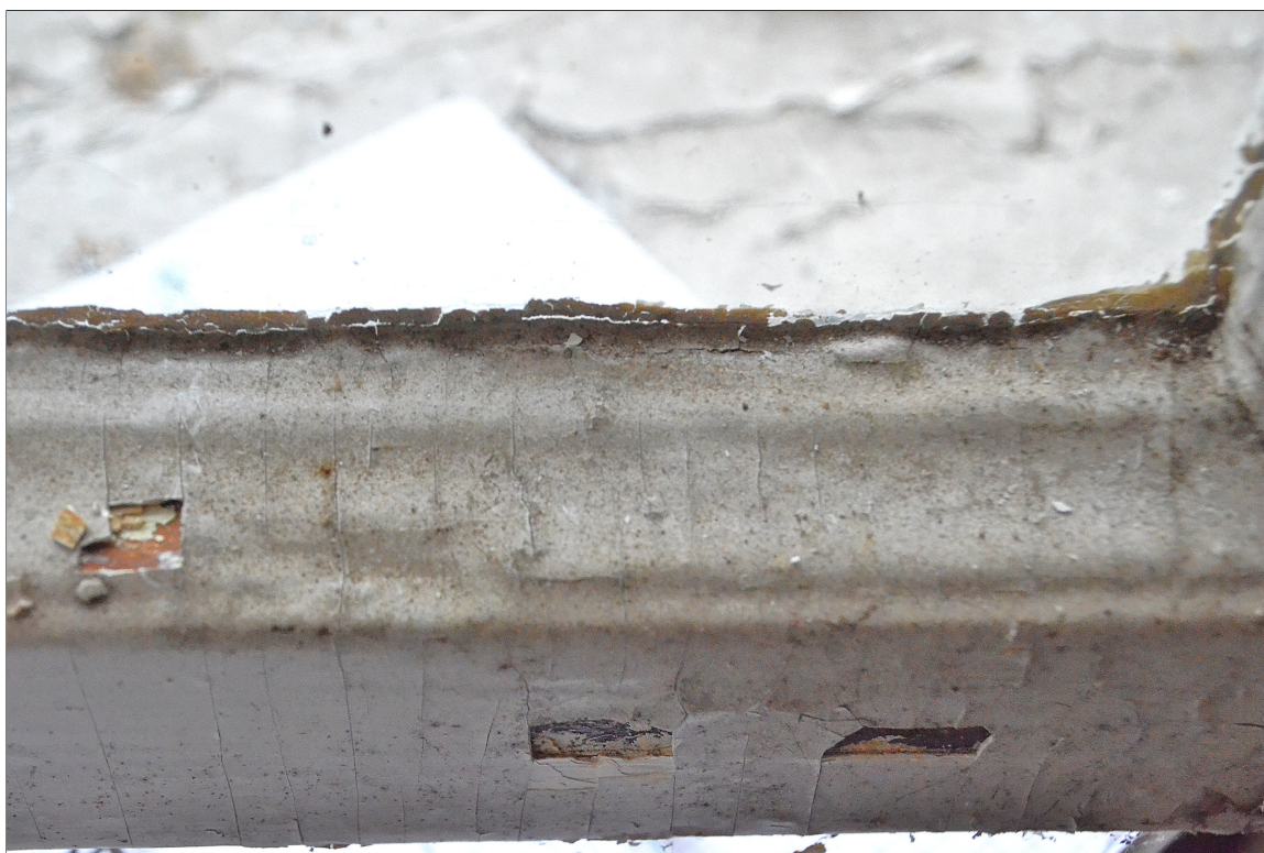
II. 7 Wieniec, Pałac – piwnica - widok na profil przyszybowy ramiaka pierwotnej stolarki okiennej pochodzącej z 70 – tych lat XIX w.
