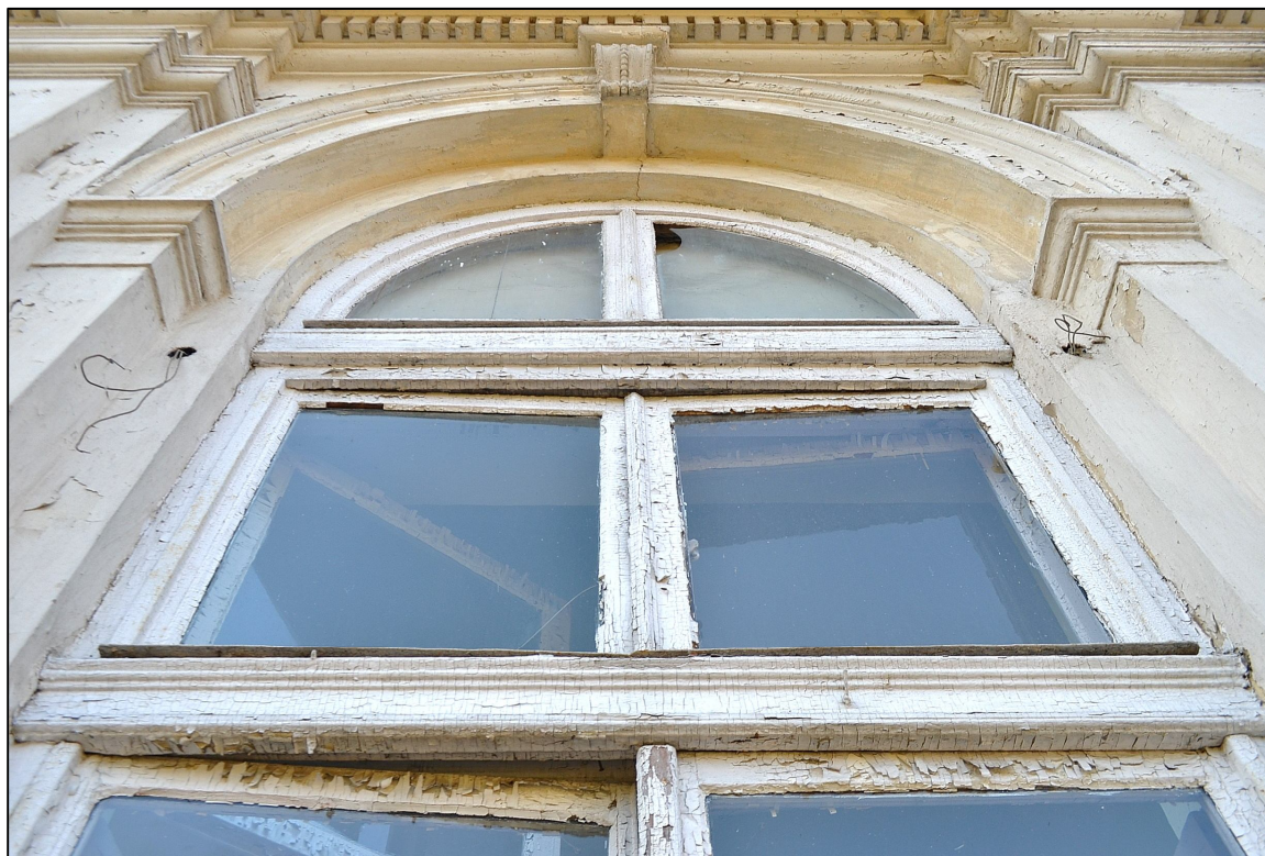
II. 138 Wieniec, Pałac – I piętro – elewacja wschodnia - stolarka drzwiowa TYP D – awers – otwór nr 35
