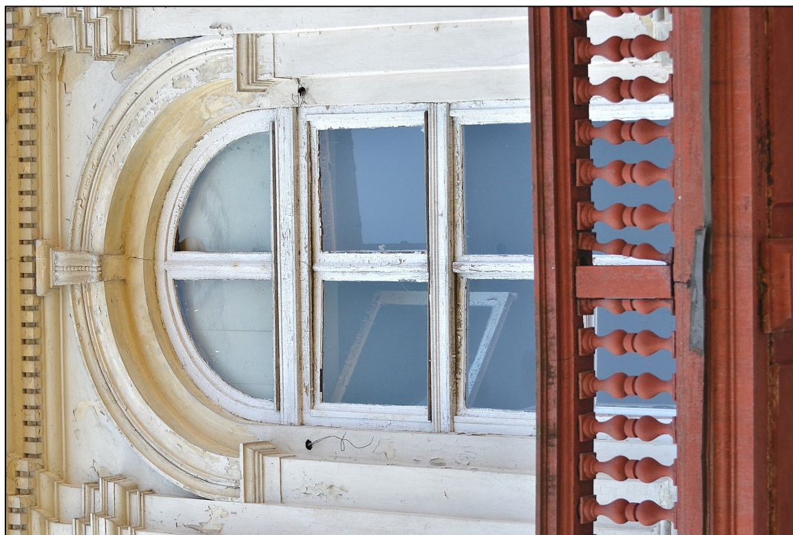
II. 136 Wieniec – Pałac – I piętro - elewacja wschodnia - stolarka drzwiowa TYP D – awers – otwór nr 35
