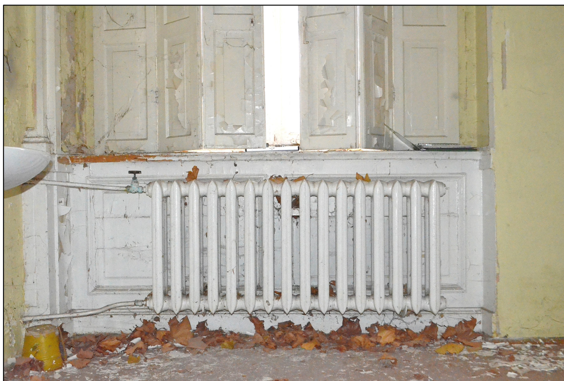
II. 35 Wieniec, Pałac – parter – elewacja południowa
