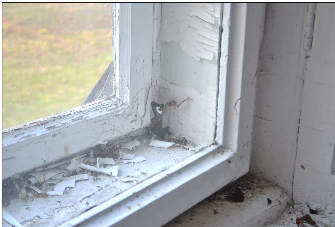
II. 48 Wieniec, Pałac – parter – elewacja południowa
