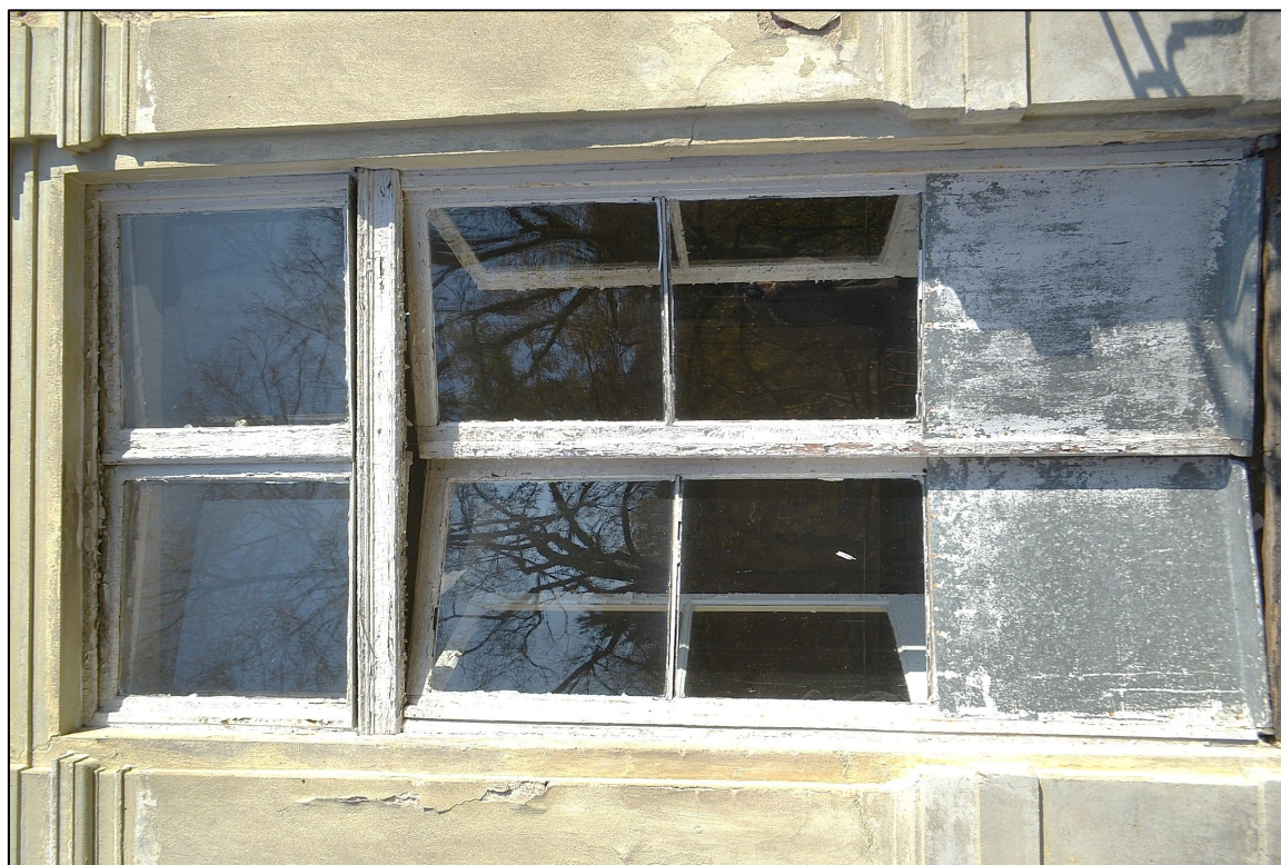
II. 144 Wieniec – Pałac – I piętro - elewacja zachodnia
