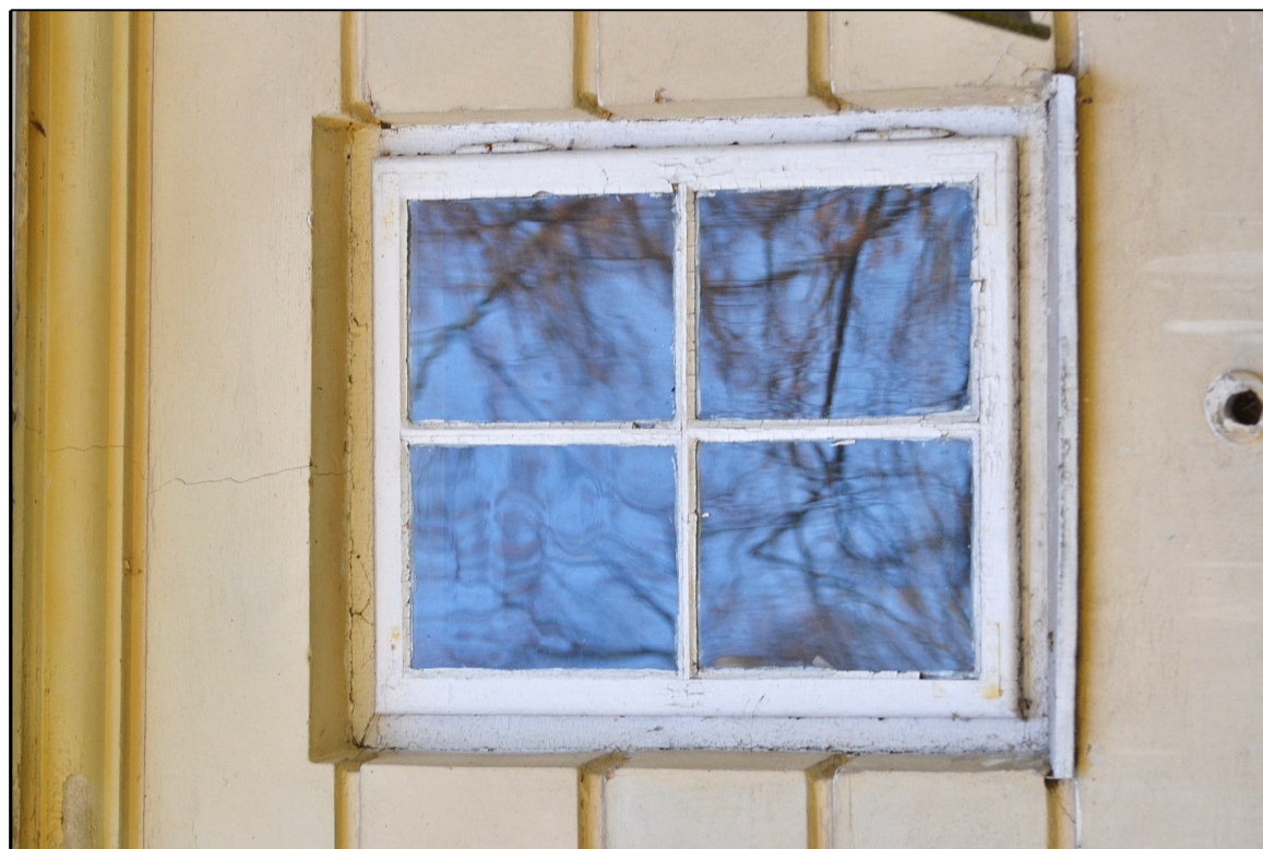
II. 54 Wieniec – Pałac – parter – elewacja zachodnia - widok na awers stolarki okiennej TYP VI - okno nr 32 fot. Ewa Bożejewicz 2014 r.
