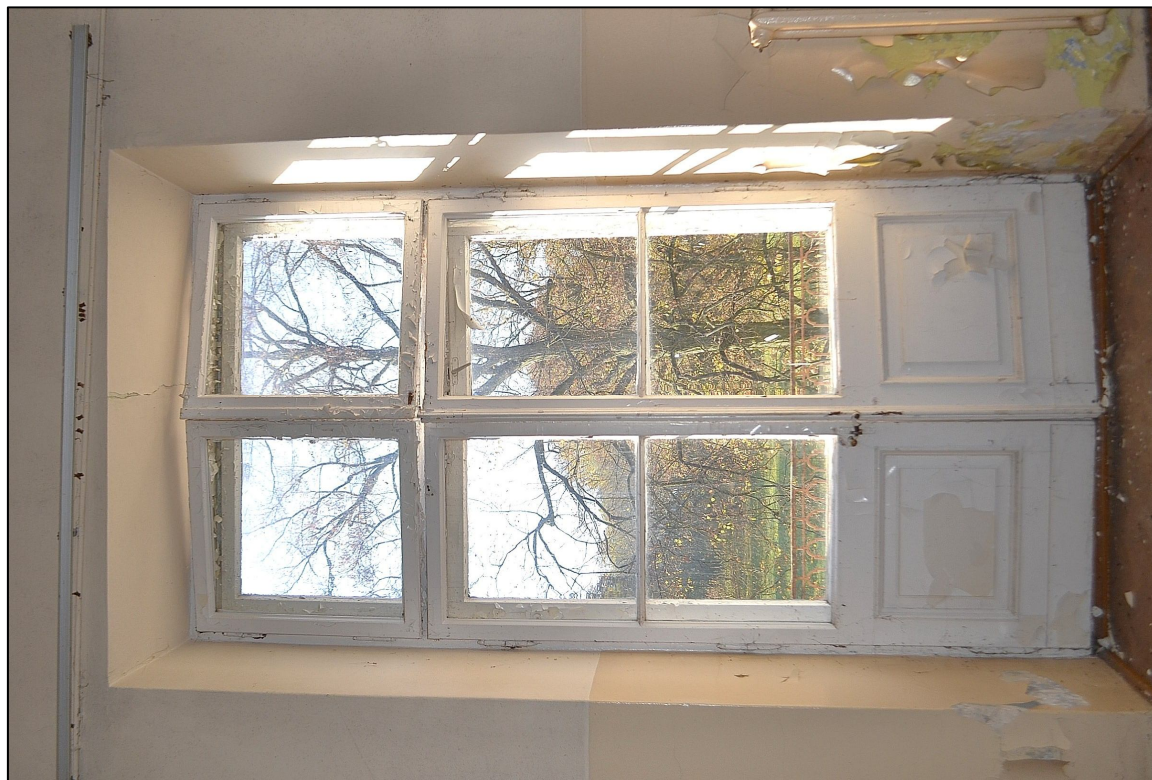
II. 145 Wieniec – Pałac – I piętro - elewacja zachodnia
