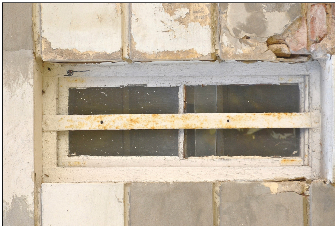
II. 64 Wieniec – Pałac – parter – elewacja zachodnia
