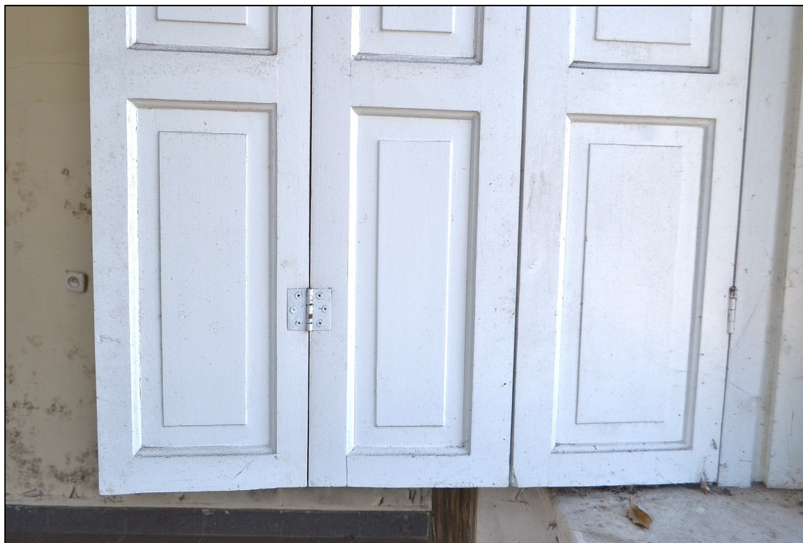
II. 100 Wieniec, Pałac – parter
