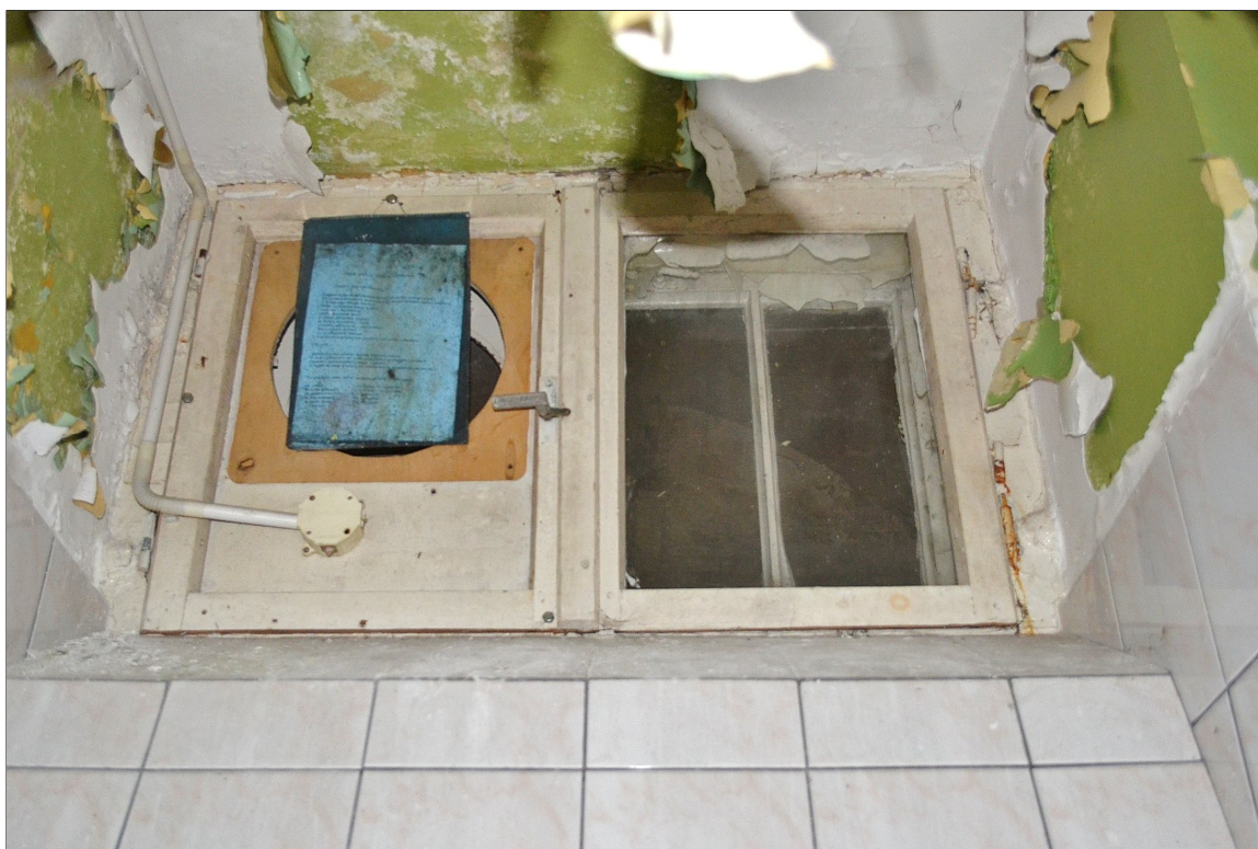
II. 5 Wieniec, Pałac – piwnica – elewacja zachodnia - widok na rewers stolarki okiennej TYP I C - okno nr 14
