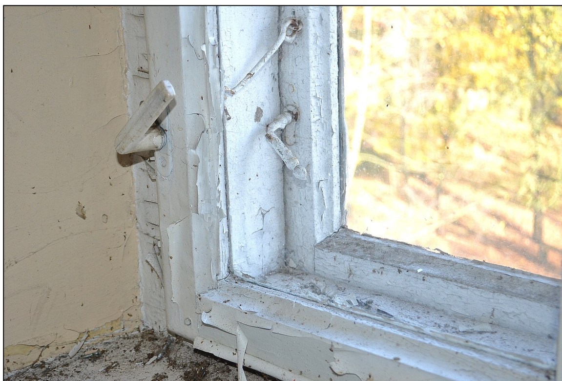
II. 157 Wieniec – Pałac – I piętro - elewacja zachodnia - stolarka drzewiowa TYP VI – widok na fragment stolarki okiennej
