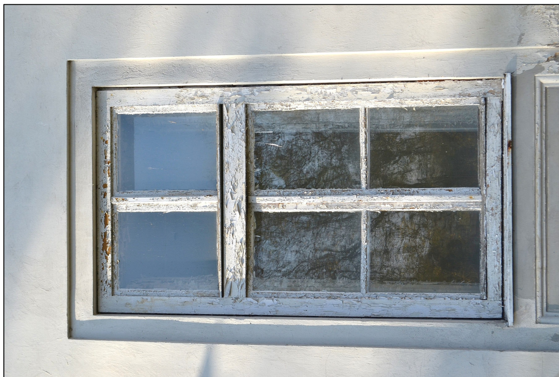
II. 46 Wieniec – Pałac – parter – elewacja wschodnia - widok na awers stolarki okiennej TYP VC - okno nr 46 fot. Ewa Bożejewicz 2014 r.
