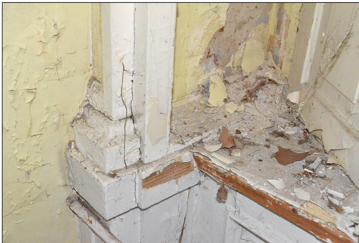
II. 32 Wieniec, Pałac – parter – elewacja południowa - stolarka okienna TYP IVA – okno nr 14 – widok na skrzynkę okiennicy
