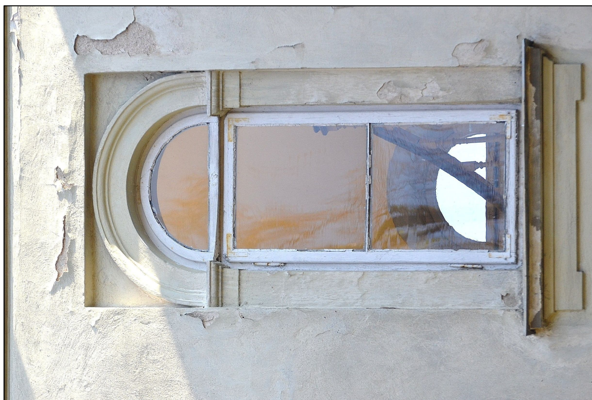
II. 130 Wieniec – Pałac – I piętro - elewacja zachodnia
