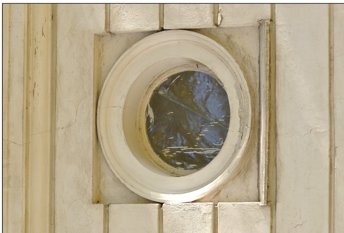
II. 70 Wieniec – Pałac – parter
