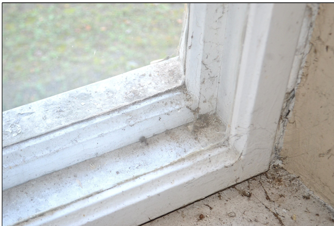
II. 62 Wieniec – Pałac – parter – elewacja północna
