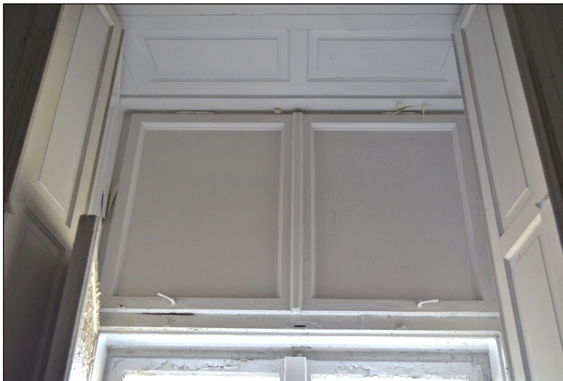
II. 94 Wieniec, Pałac – parter
