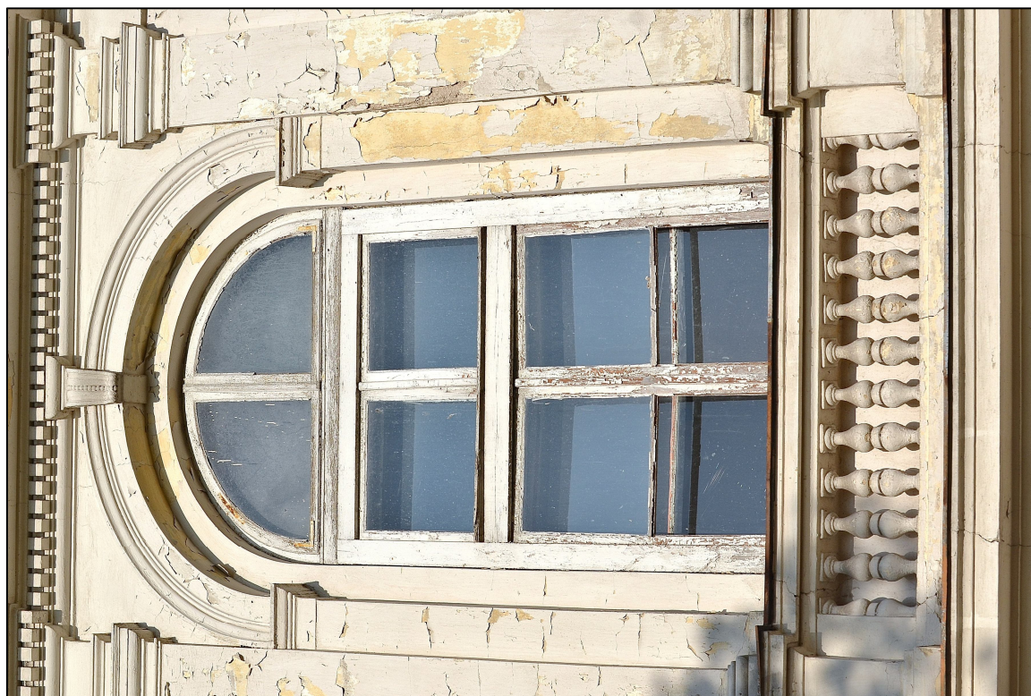
II. 102 Wieniec – Pałac – I piętro - elewacja południowa - widok na rewers stolarki okiennej TYP IV D – okno nr 1
