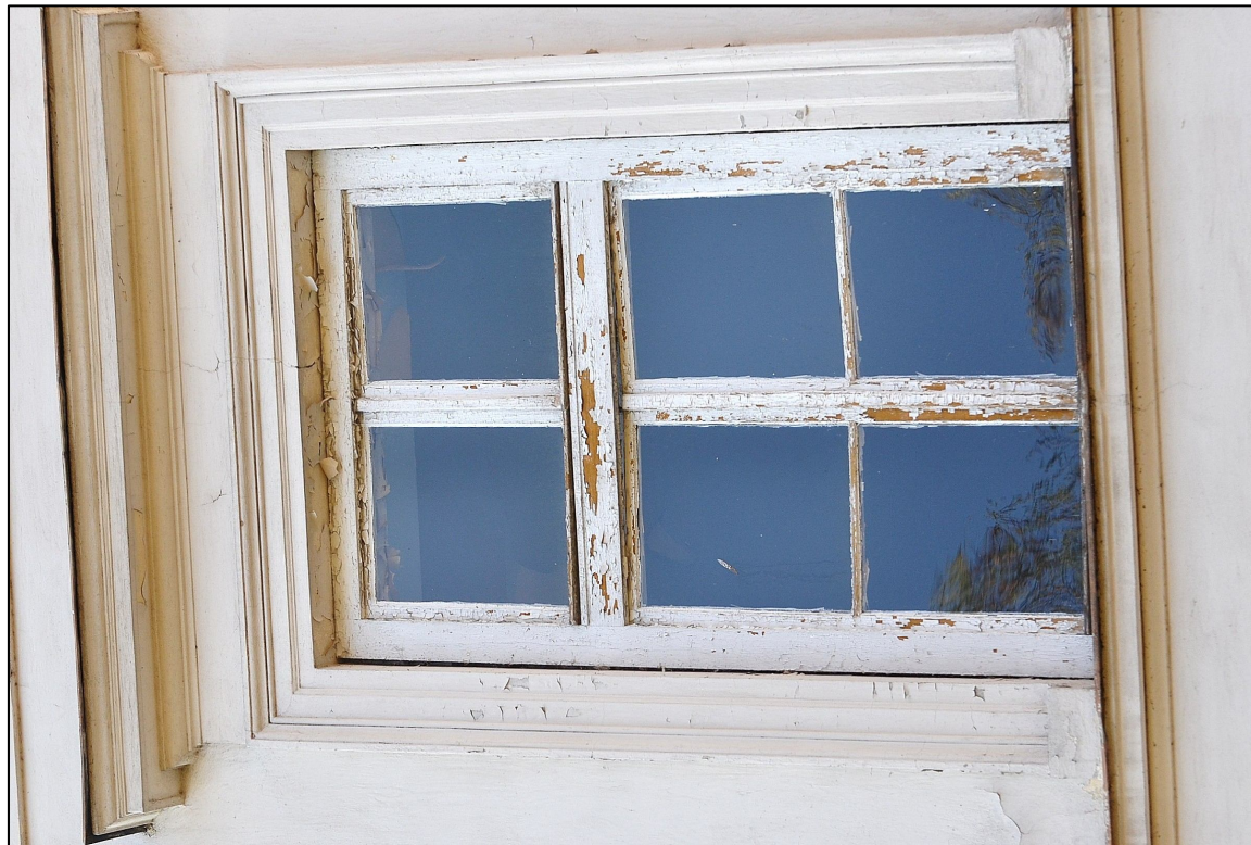
II. 103 Wieniec – Pałac – I piętro - elewacja zachodnia - widok na awers stolarki okiennej TYP VC
