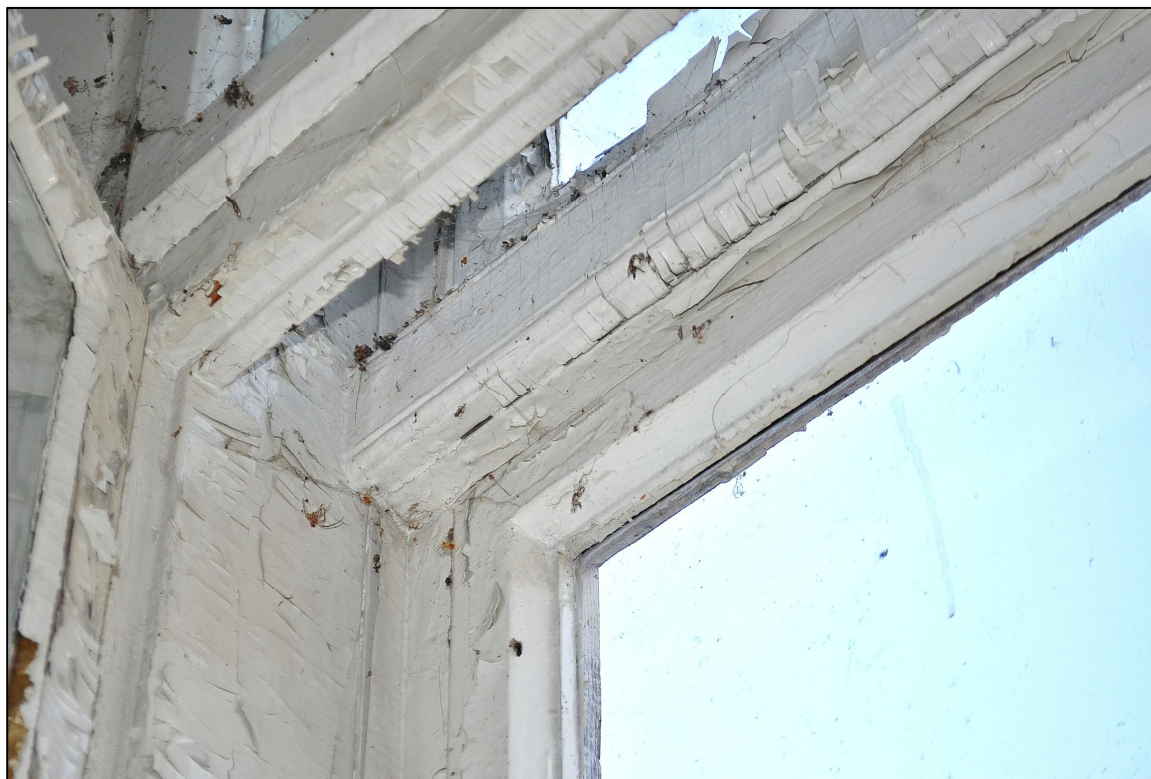
II. 108 Wieniec, Pałac – I piętro
