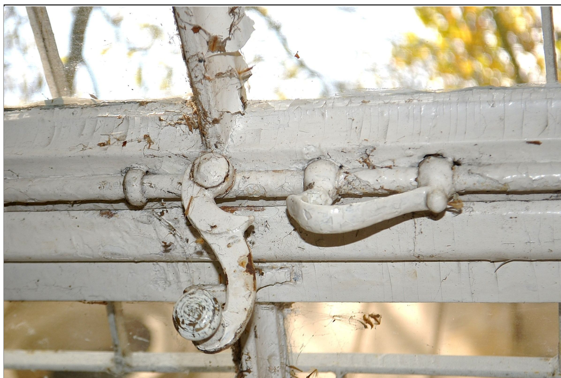
II. 29 Wieniec, Pałac – parter – elewacja południowa - stolarka okienna TYP IVA – okno nr 14 – widok na fragment zawrotnicy
