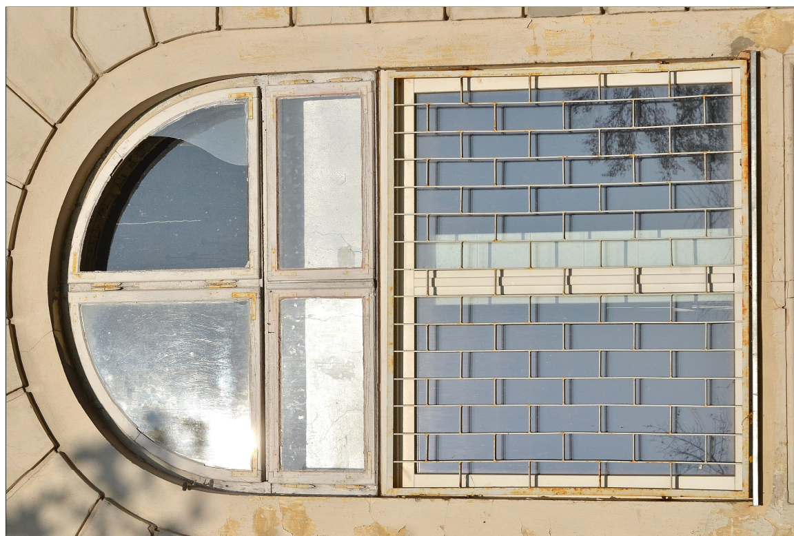
II. 36 Wieniec – Pałac – parter – elewacja południowa - widok na awers stolarki okiennej TYP IVB - okno nr 1 fot. Ewa Bożejewicz 2014 r.
