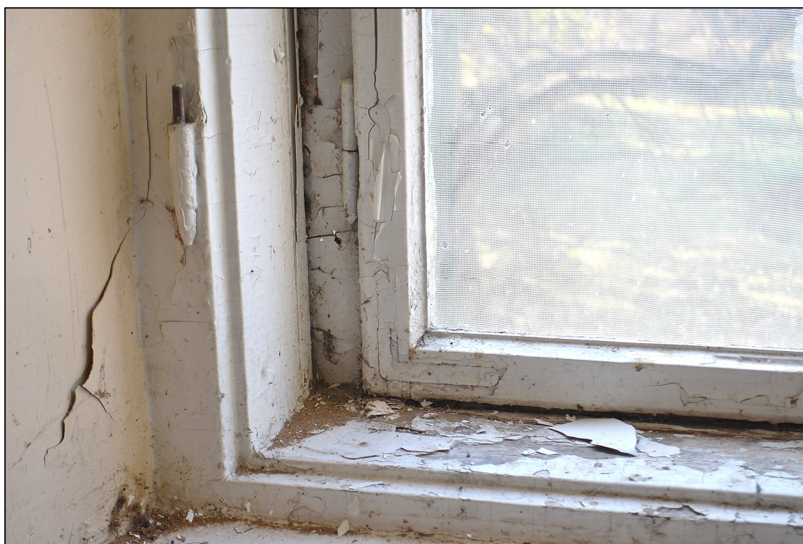
II. 107 Wieniec, Pałac – I piętro
