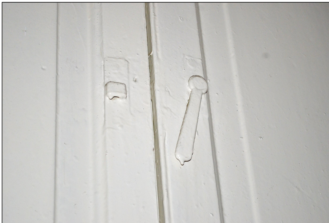
II. 98 Wieniec, Pałac – parter
