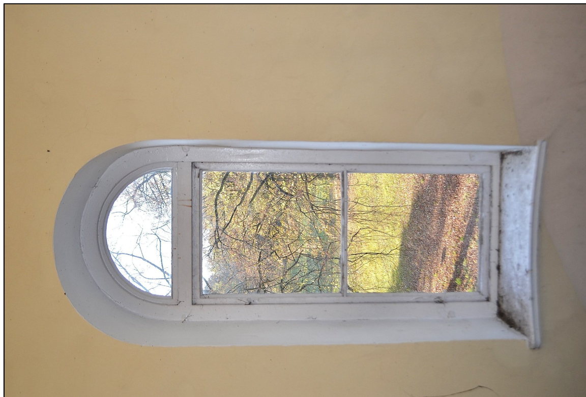
II. 131 Wieniec – Pałac – I piętro - elewacja zachodnia
