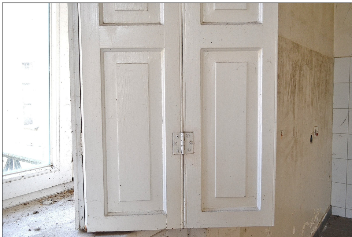
II. 101 Wieniec, Pałac – parter
