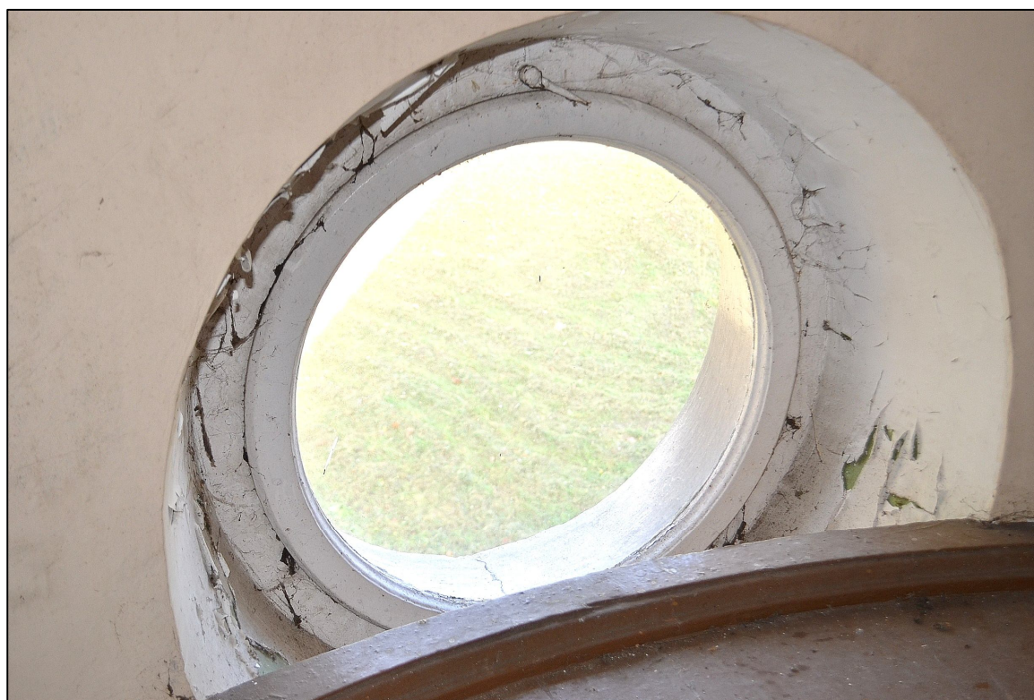
II. 72 Wieniec – Pałac – parter – elewacja południowa - widok na rewers stolarki okiennej TYP XI - okno nr 9
