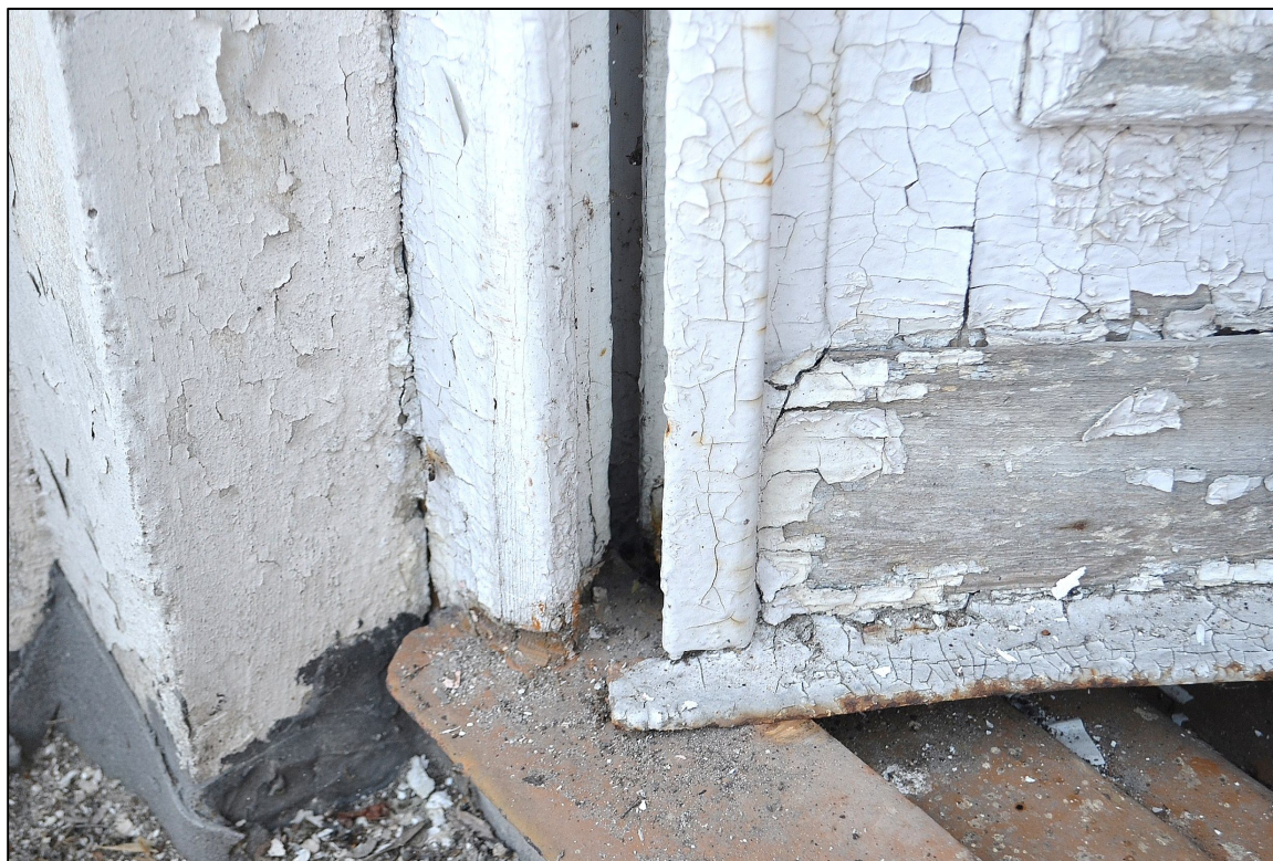
II. 140 Wieniec, Pałac – I piętro – elewacja wschodnia
