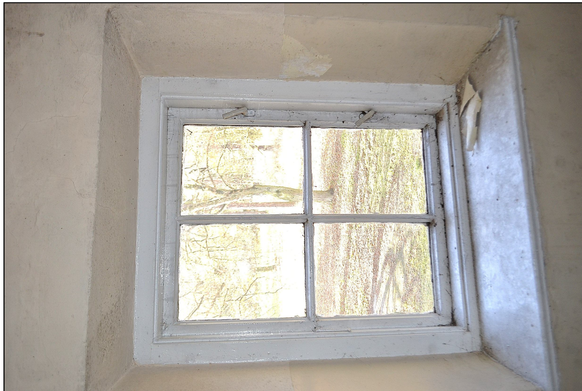
II. 55 Wieniec – Pałac – parter – elewacja zachodnia - widok na rewers stolarki okiennej TYP VI – okno nr 32 fot. Ewa Bożejewicz 2014 r.
