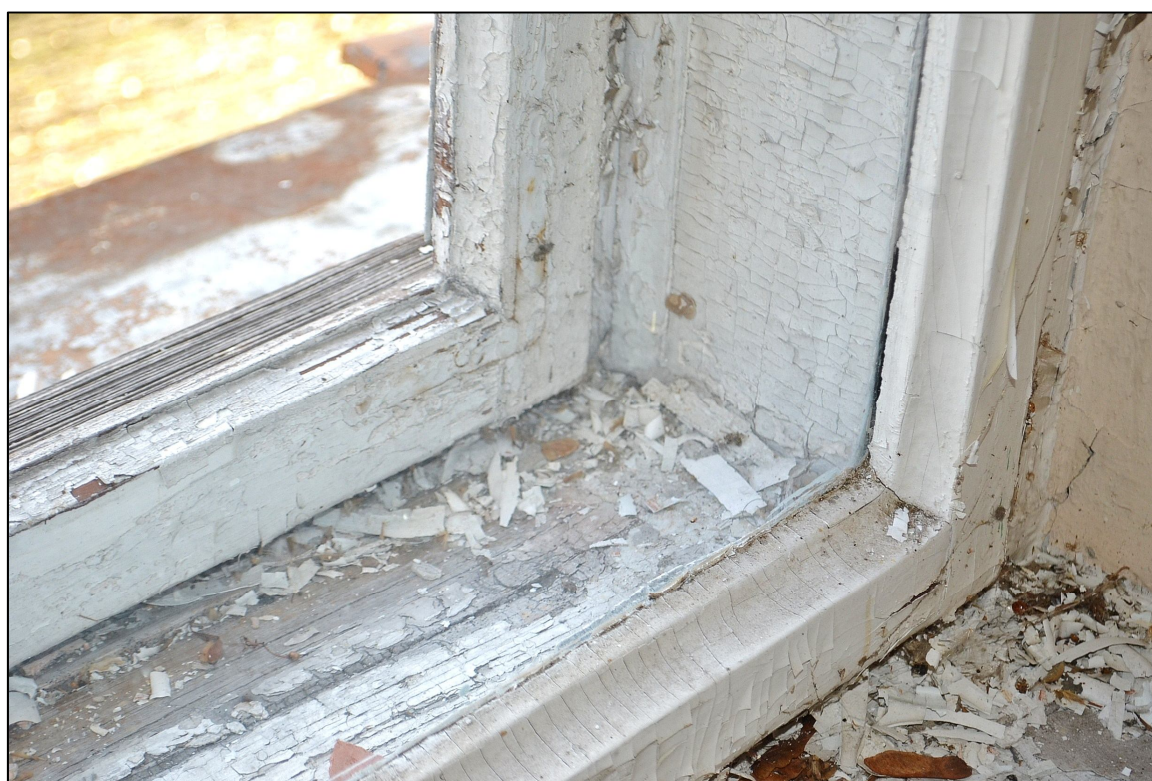
II. 105 Wieniec, Pałac – I piętro - elewacja południowa - stolarka okienna TYP VC– widok na fragment okna
