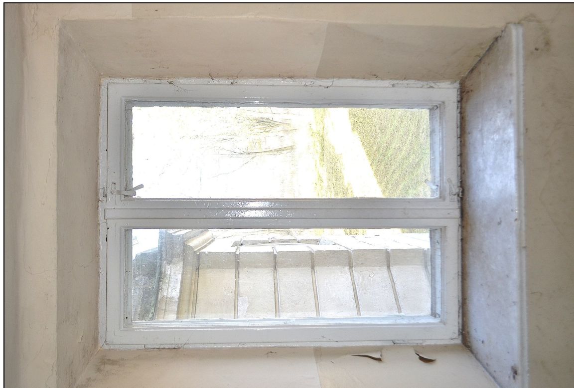
II. 61 Wieniec – Pałac – parter – elewacja północna - widok na rewers stolarki okiennej TYP IX - okno nr 42 fot. Ewa Bożejewicz 2014 r.
