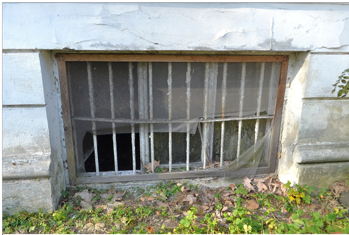
II. 20 Wieniec, Pałac – piwnica – elewacja wschodnia - widok na awers stolarki okiennej TYP III – okno nr 43
