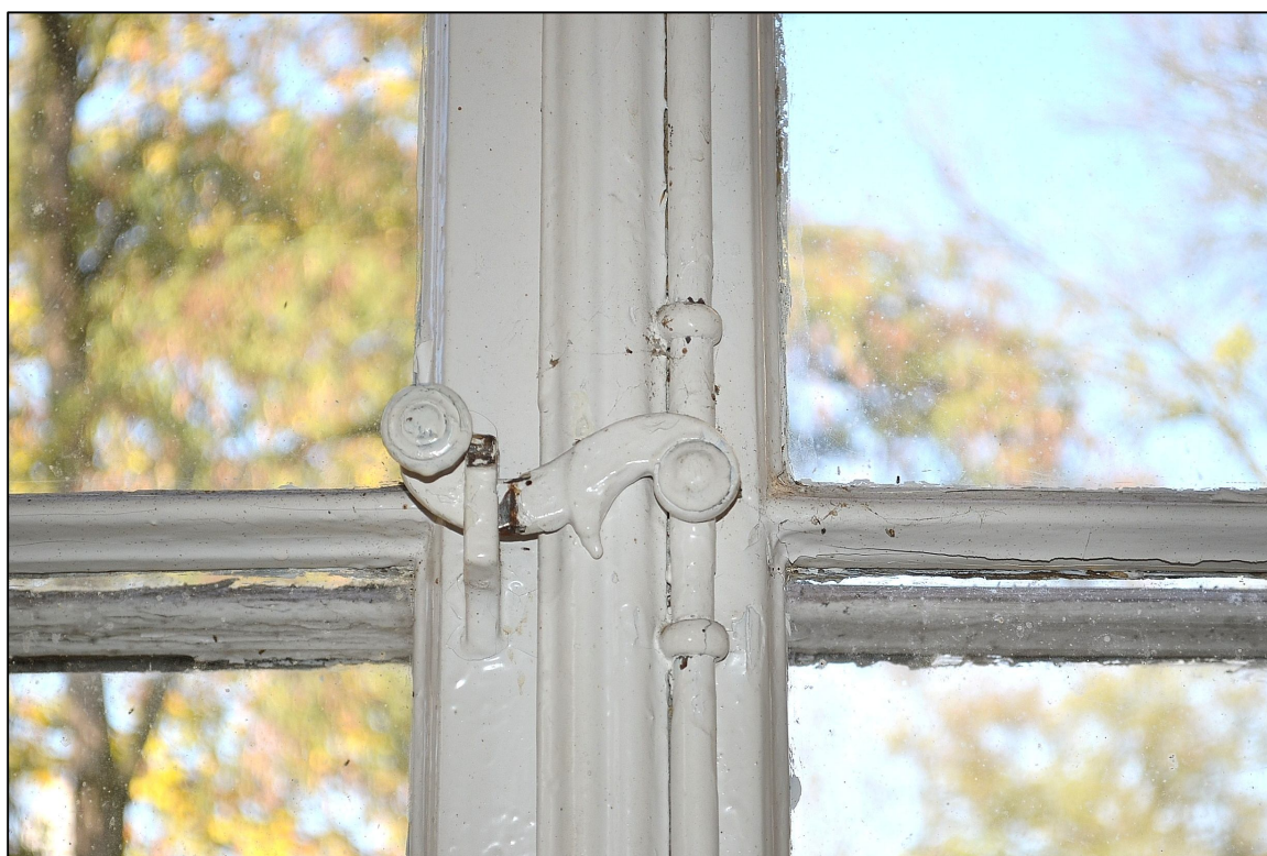
II. 125 Wieniec, Pałac – I piętro
