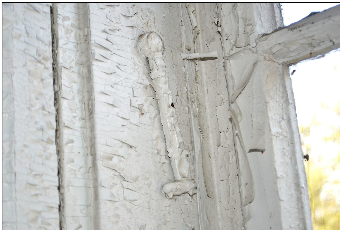
II. 114 Wieniec, Pałac – I piętro
