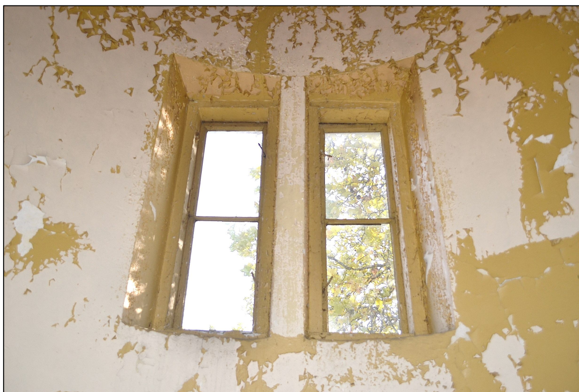
II.159 Wieniec – Pałac – ostatnia kondygnacja wieży - widok na rewers stolarki okiennej TYP XIV
