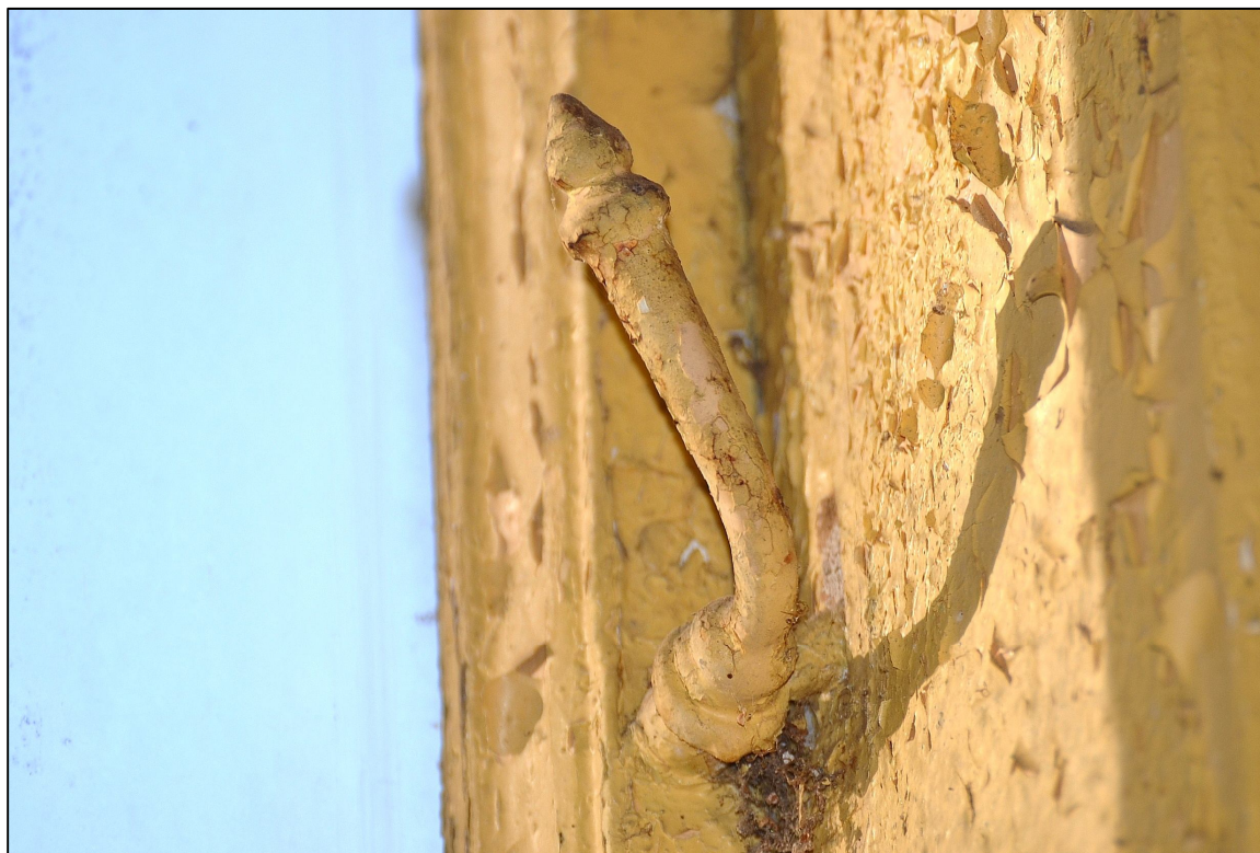
II.160 Wieniec – Pałac – ostatnia kondygnacja wieży - stolarka okienna TYP XIV – widok na pierwotną zakrętkę
