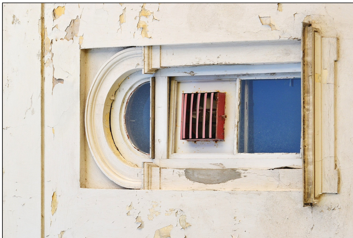
II. 132 Wieniec – Pałac – I piętro - elewacja zachodnia
