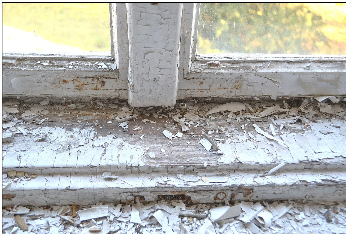
II. 116 Wieniec, Pałac – I piętro
