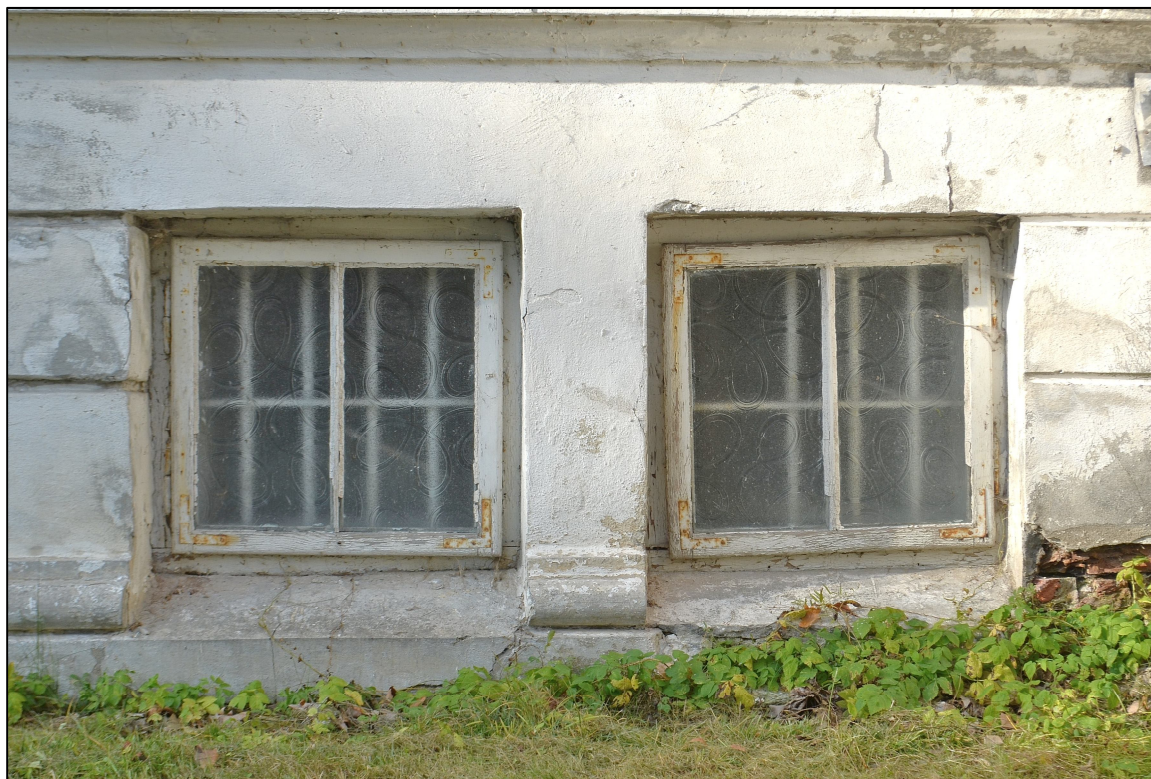
II. 8 Wieniec, Pałac – piwnica – elewacja wschodnia - widok na awers stolarki okiennej TYP II A - okno nr 36 i 37
