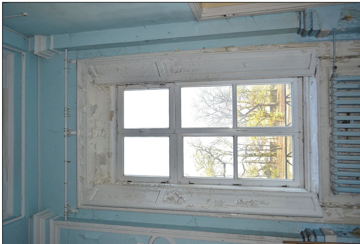
II. 41 Wieniec – Pałac – parter – elewacja wschodnia - widok na awers stolarki okiennej TYP VA - okno nr 48 fot. Ewa Bożejewicz 2014 r.
