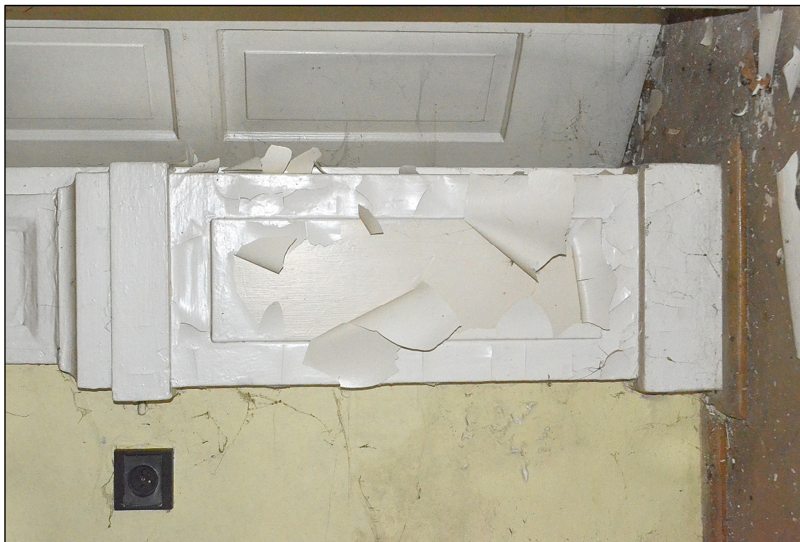
II. 34 Wieniec, Pałac – parter – elewacja południowa
