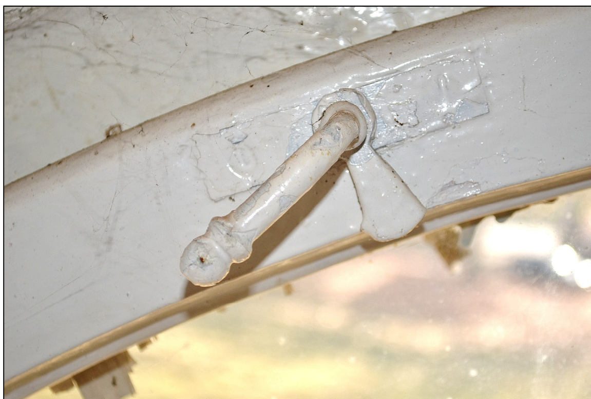
II. 75 Wieniec, Pałac – parter
