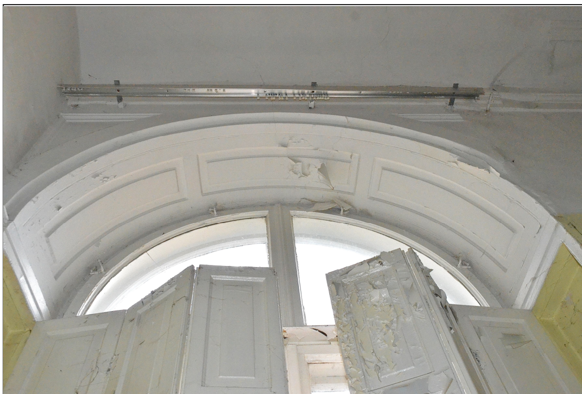
II. 30 Wieniec, Pałac – parter – elewacja południowa - stolarka okienna TYP IVA – okno nr 14 – widok na dekoracyjne opierzenie podniebienia łuku
