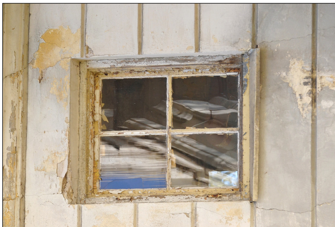
II. 50 Wieniec – Pałac – parter – elewacja wschodnia - widok na awers stolarki okiennej TYP VI - okno nr 5
