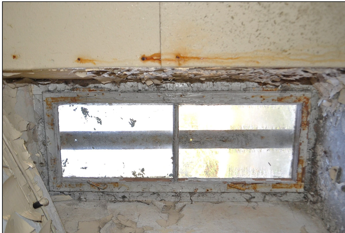
II. 65 Wieniec – Pałac – parter – elewacja wschodnia
