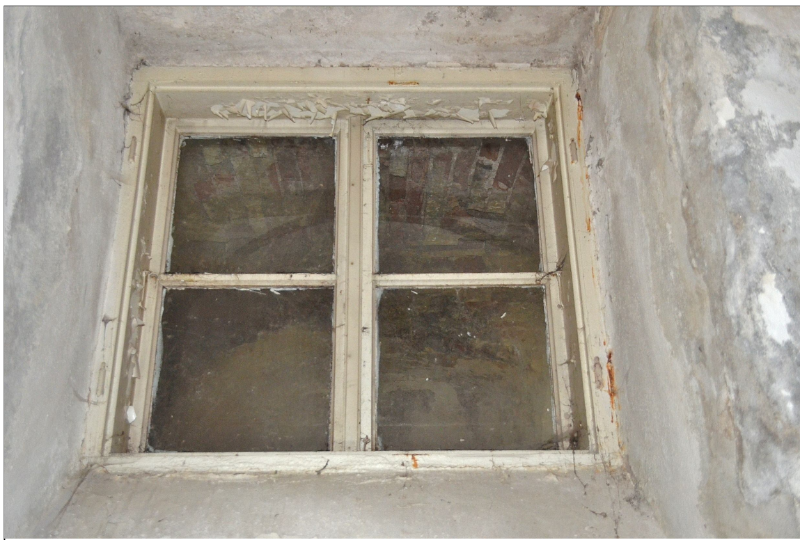
II. 14 Wieniec, Pałac – piwnica – elewacja zachodnia - widok na rewers ościeżnicowej stolarki okiennej TYP I B - okno nr 14 – brak skrzydeł wewn.
