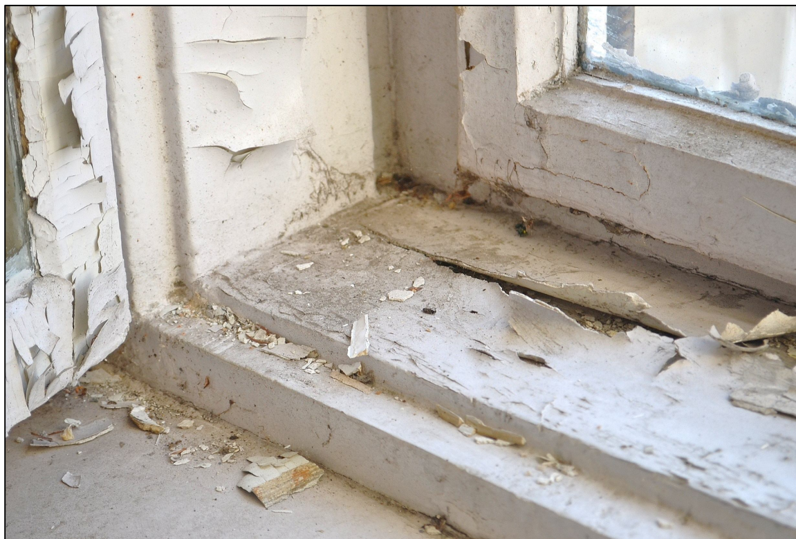
II. 106 Wieniec, Pałac – I piętro
