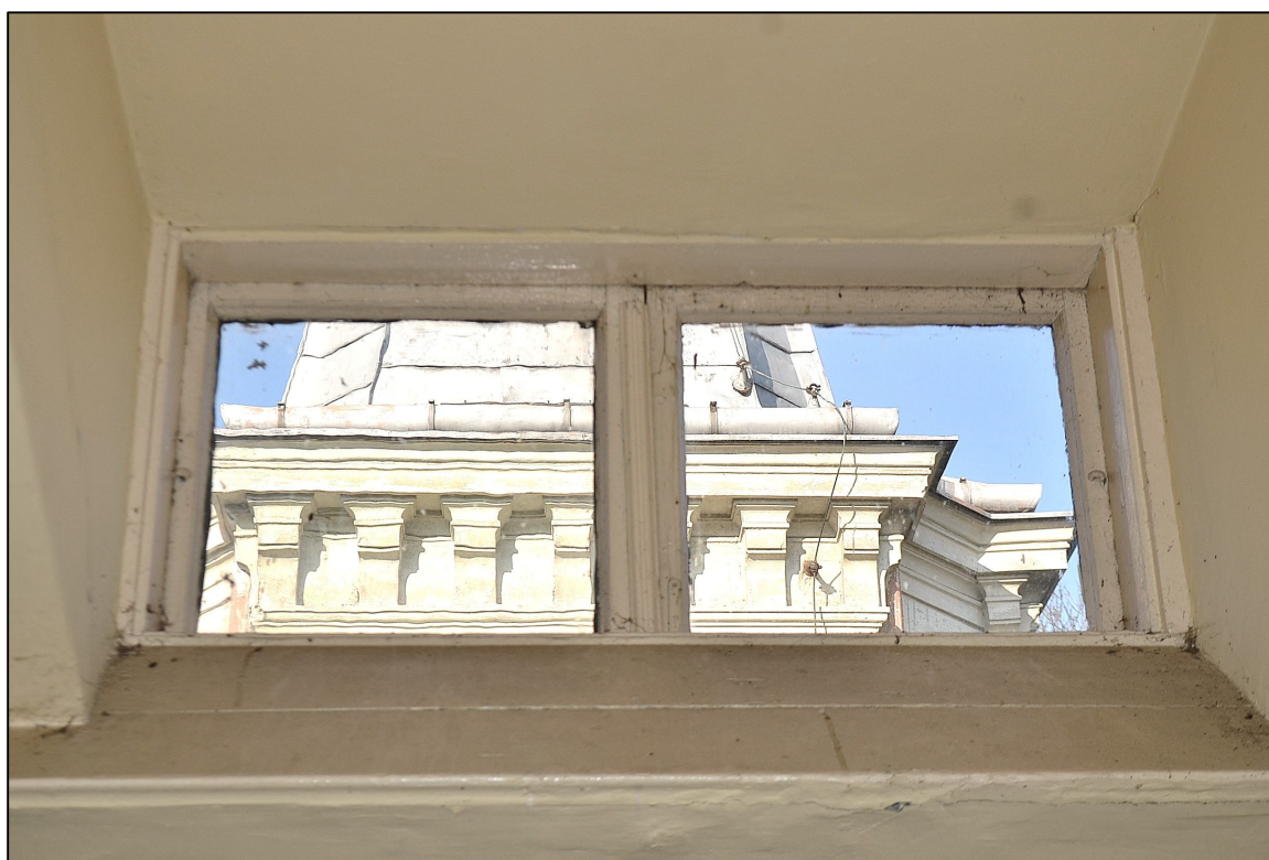
II. 161 Wieniec – Pałac – elewacja północna - stolarka okienna TYP XVb - doświetlająca ostatnią bieg schodów w północnej klatce schodowej
