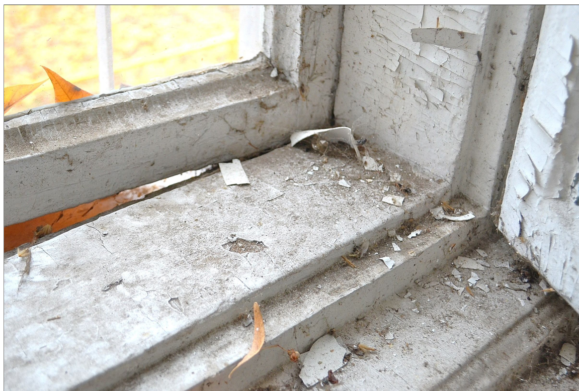
II. 9 Wieniec, Pałac – piwnica – elewacja wschodnia - widok na ościeżnicę stolarki okiennej TYP II A
