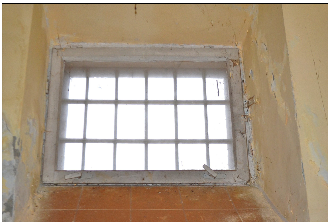
II. 19 Wieniec, Pałac – piwnica – elewacja południowa - widok na rewers stolarki okiennej TYP II B – okno nr 1
