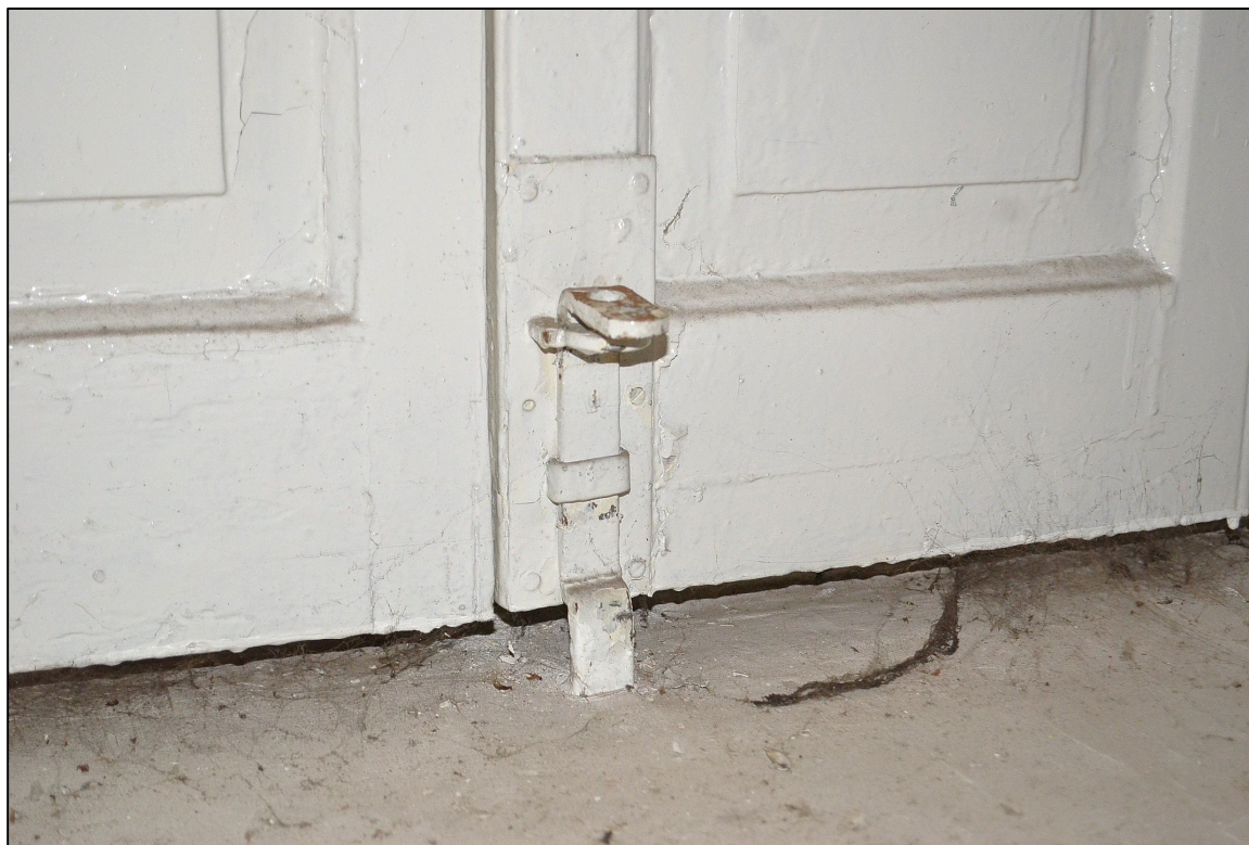
II. 96 Wieniec, Pałac – parter - pierwotna okiennica okienna – widok na zasuwkę dolną
