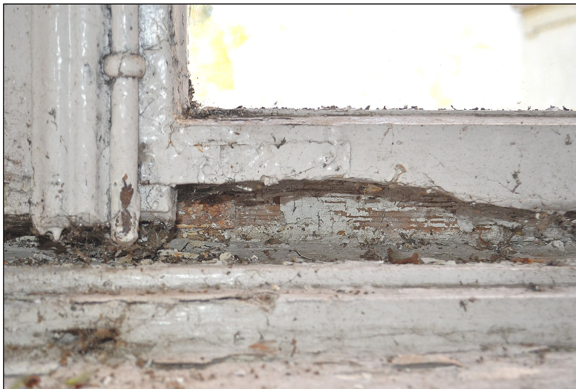
II. 122 Wieniec, Pałac – I piętro
