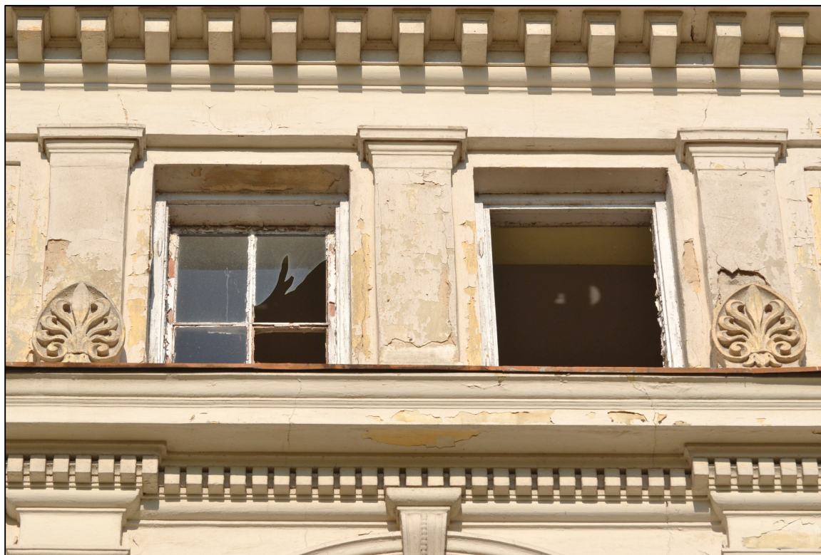
II. 152 Wieniec – Pałac – poddasze - elewacja południowa - stolarka drzwiowa TYP VI – awers – otwór nr 1 i 2
