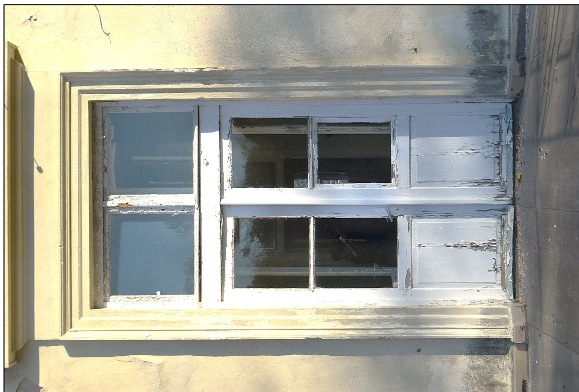
II. 148 Wieniec – Pałac – I piętro - elewacja zachodnia - stolarka drzwiowa TYP A/3– awers – otwór nr 20
