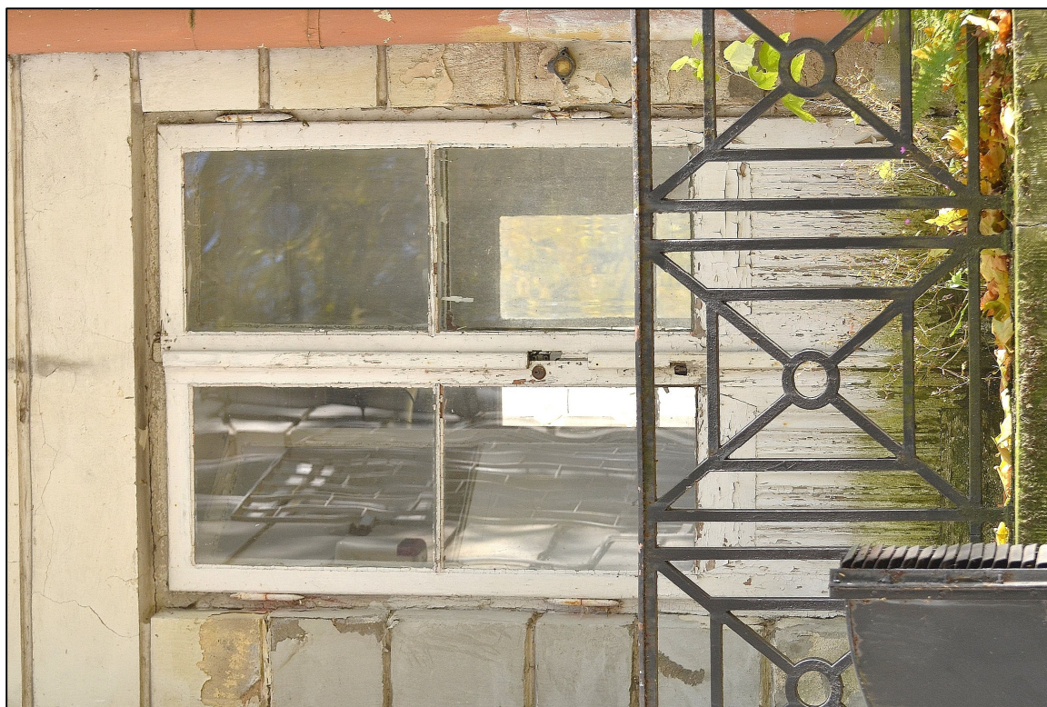
II. 88 Wieniec – Pałac – parter - elewacja zachodnia - stolarka drzwiowa TYP A/3 - widok na profile przyszybowe
