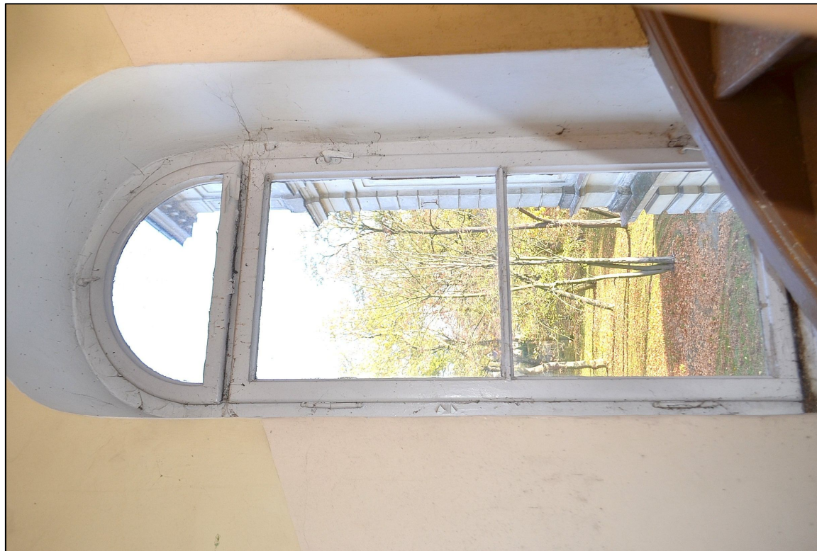
II. 135 Wieniec – Pałac – I piętro - elewacja północna
