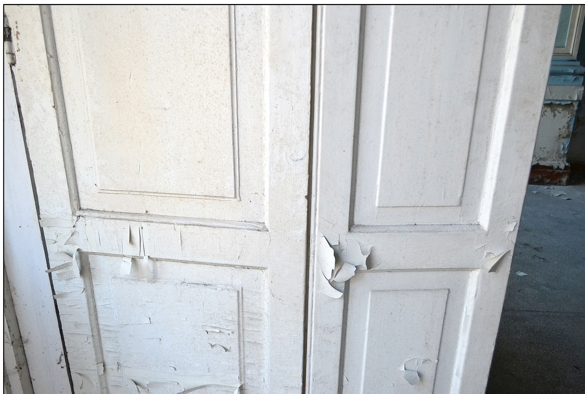
II. 93 Wieniec, Pałac – parter
