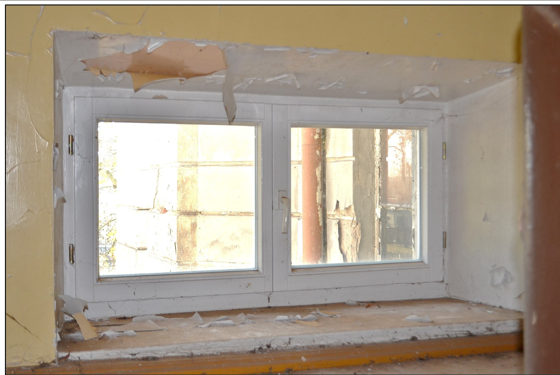
II. 79 Wieniec – Pałac – parter - elewacja południowa
