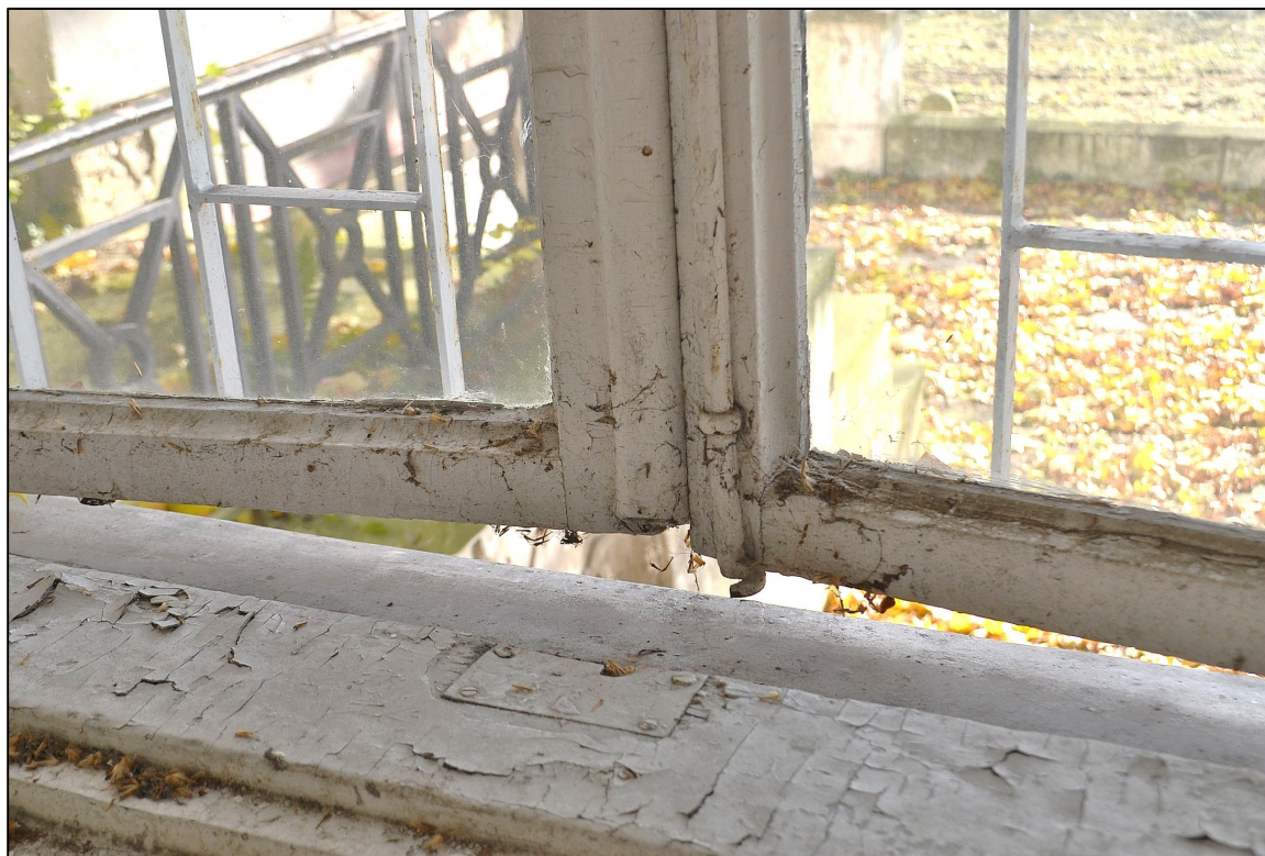
II. 28 Wieniec, Pałac – parter – elewacja południowa - stolarka okienna TYP IVA – okno nr 14 – widok na próg ościeżnicy i zawrotnicę
