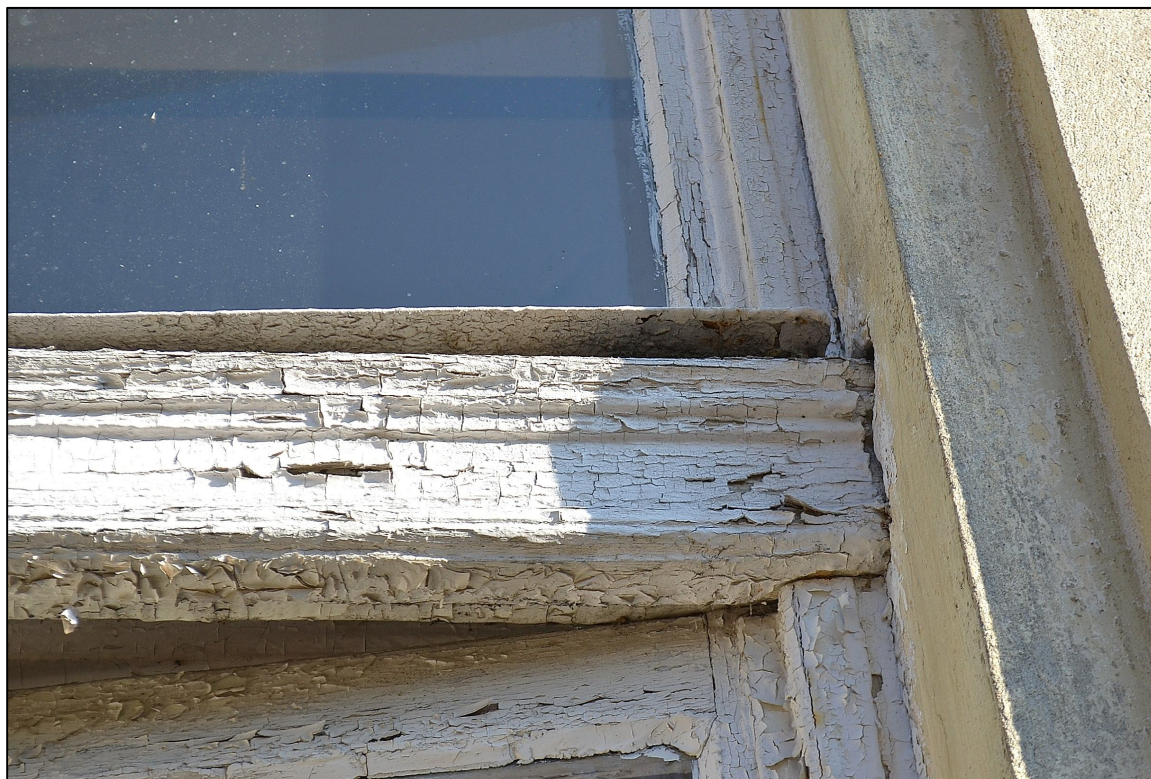
II. 146 Wieniec – Pałac – I piętro - elewacja zachodnia - stolarka drzwiowa TYP A/3 – awers – otwór nr 10 – fragment ślemienia
