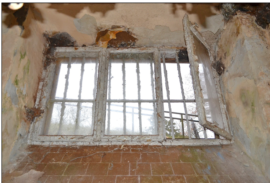
II. 21 Wieniec, Pałac – piwnica – elewacja wschodnia - widok na rewers stolarki okiennej TYP III – okno nr 43
