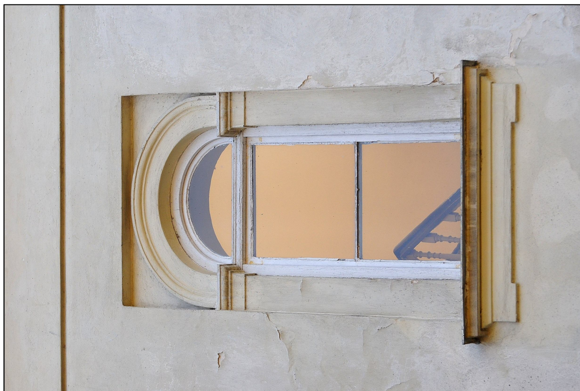
II. 134 Wieniec – Pałac – I piętro - elewacja zachodnia
