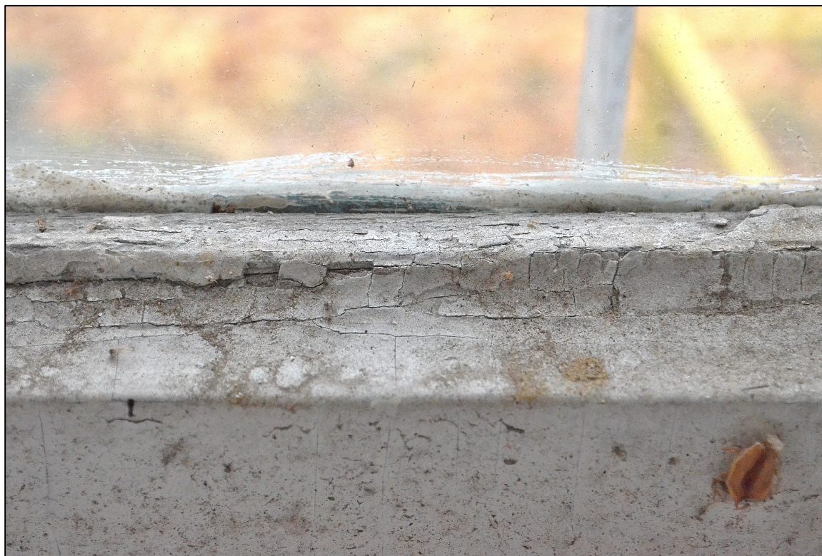
II. 22 Wieniec, Pałac – piwnica – elewacja wschodnia - widok na profil przyszybowy ramiaka stolarki okiennej pochodzącej z pocz. XX w.
