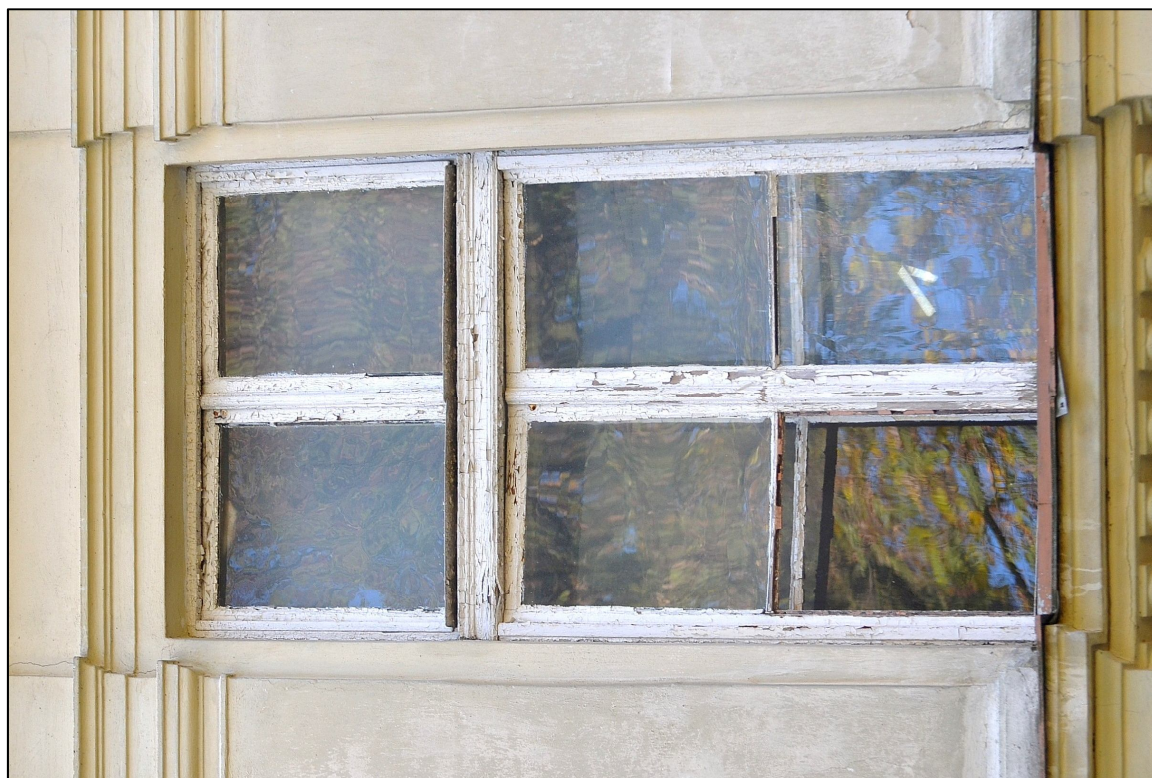
II. 112 Wieniec – Pałac – I piętro - elewacja południowa - widok na rewers stolarki okiennej TYP XII – okno nr 22 fot. Ewa Bożejewicz 2014 r.
