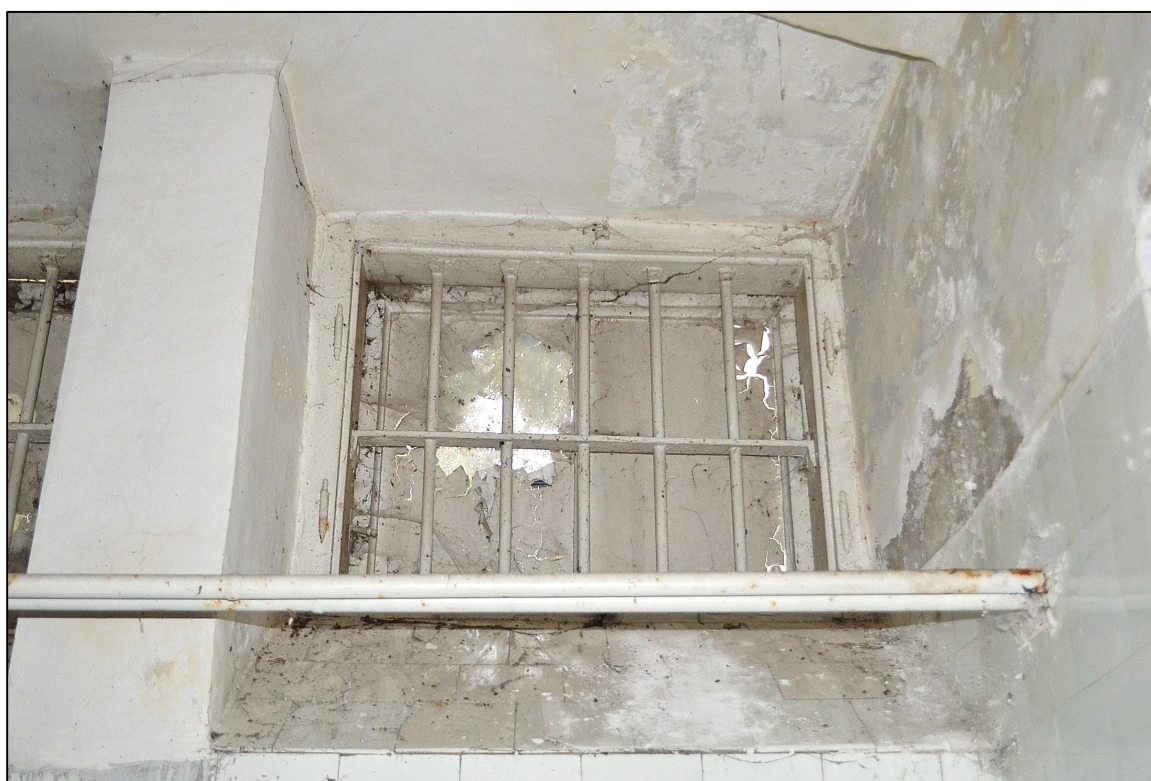
II. 11 Wieniec, Pałac – piwnica – elewacja wschodnia - widok na rewers stolarki okiennej TYP II A - okno nr 34 i 35
