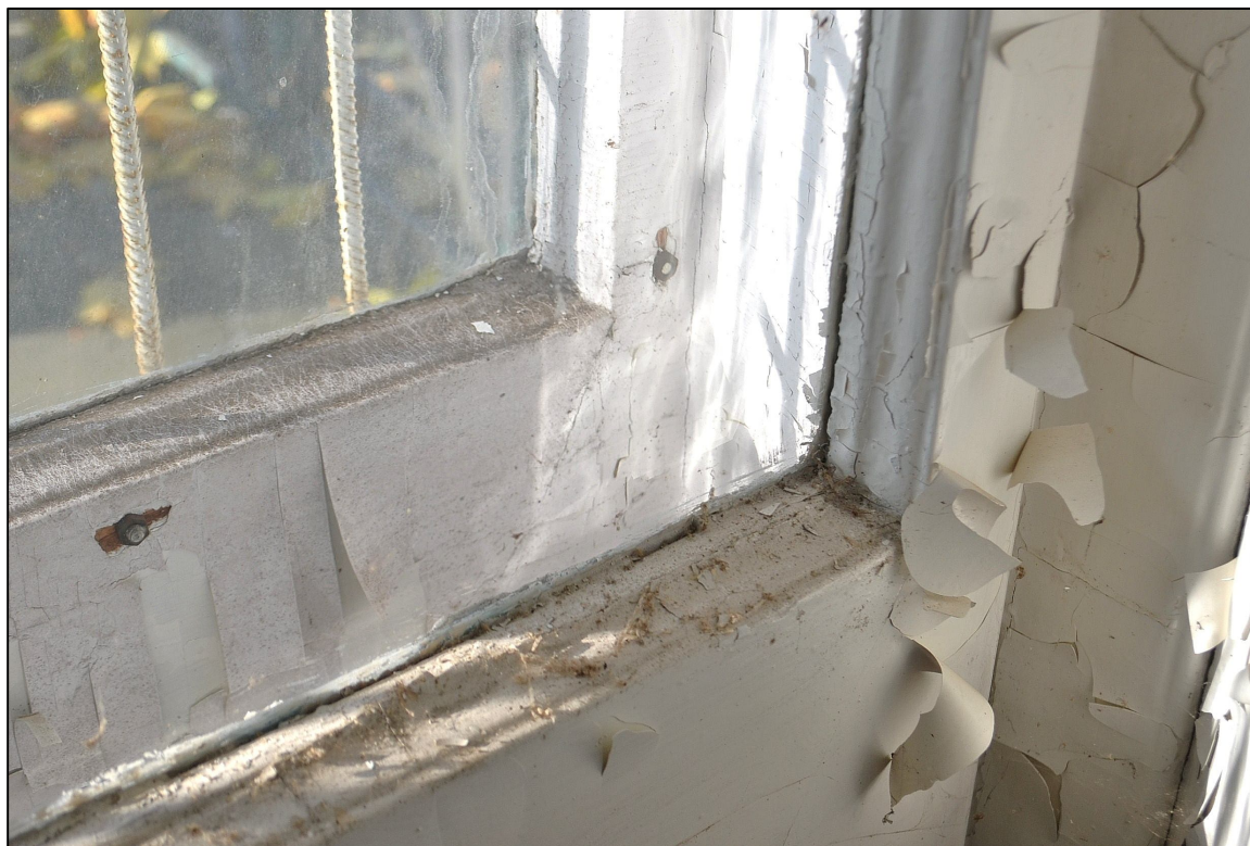
II. 82 Wieniec, Pałac – parter – elewacja zachodnia - stolarka drzwiowa TYP C/1 – widok na profile przyszybowe
