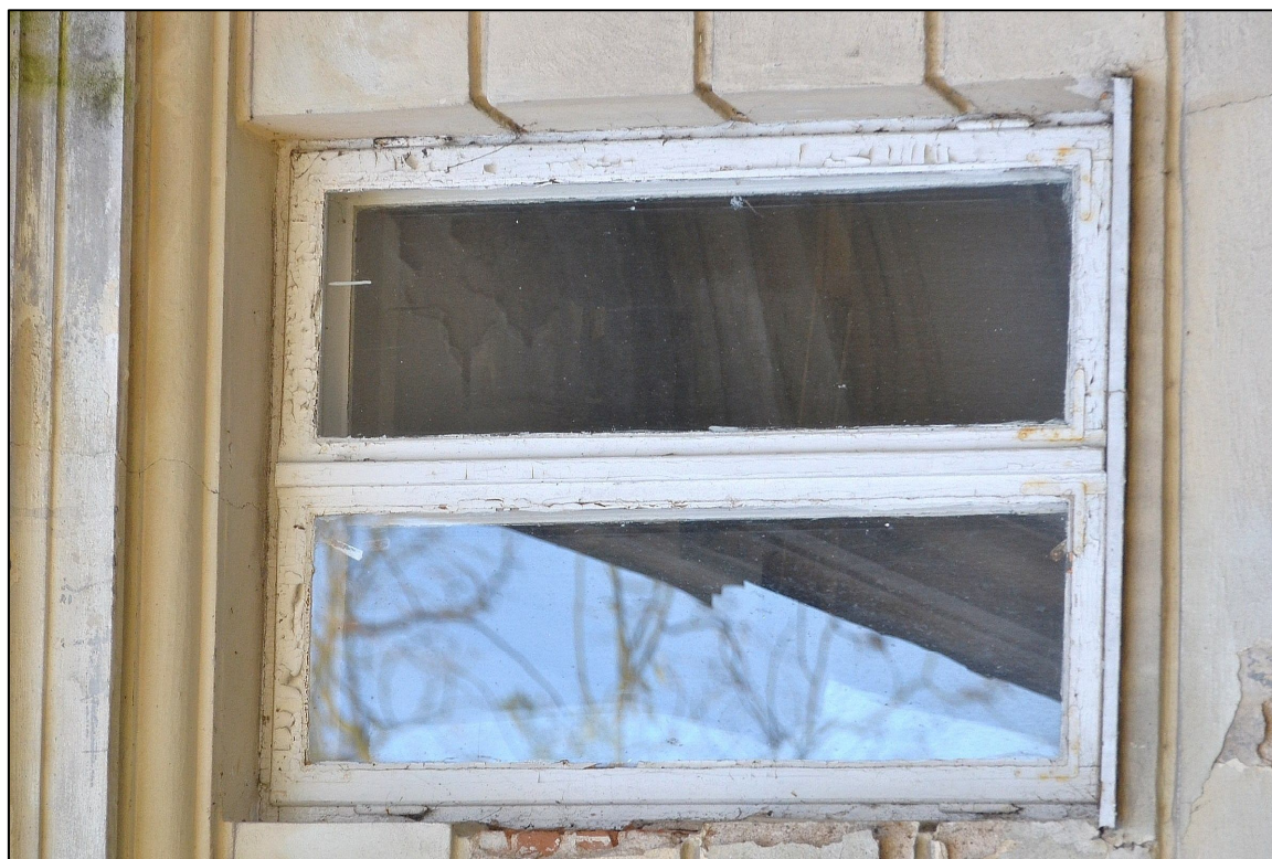
II. 60 Wieniec – Pałac – parter – elewacja północna - widok na awers stolarki okiennej TYP IX - okno nr 42 fot. Ewa Bożejewicz 2014 r.
