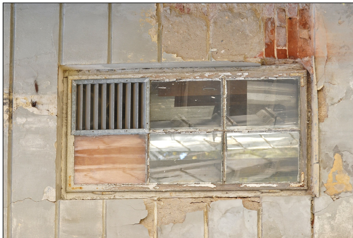
II. 56 Wieniec – Pałac – parter – elewacja wschodnia - widok na awers stolarki okiennej TYP VIIA - okno nr 4 fot. Ewa Bożejewicz 2014 r.
