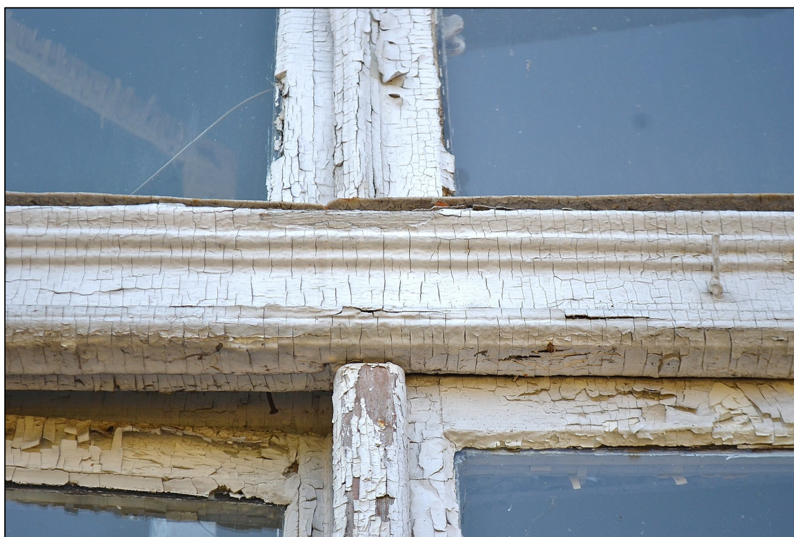
II. 139 Wieniec, Pałac – I piętro – elewacja wschodnia - stolarka drzwiowa TYP D – awers – otwór nr 35 – widok na ślemię
