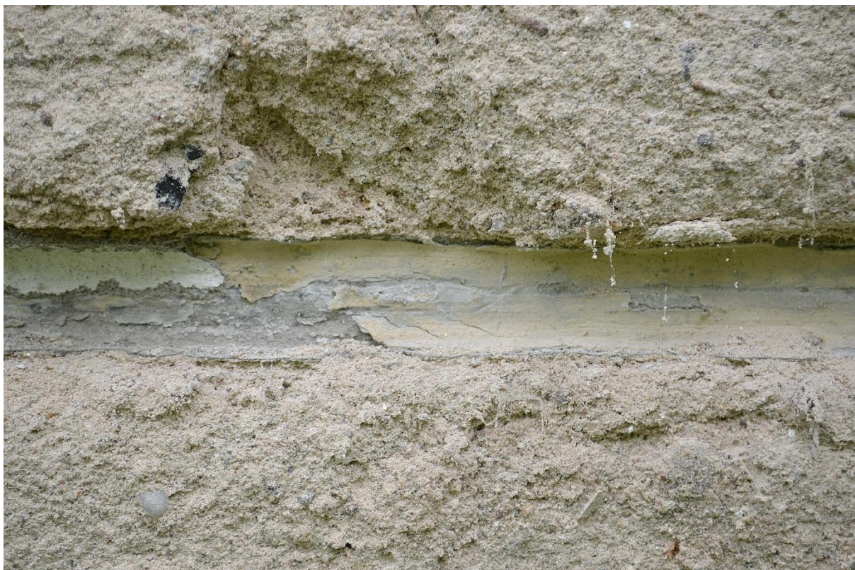
Odkrywka (3) Na boniowaniu ściany elewacji wschodniej
