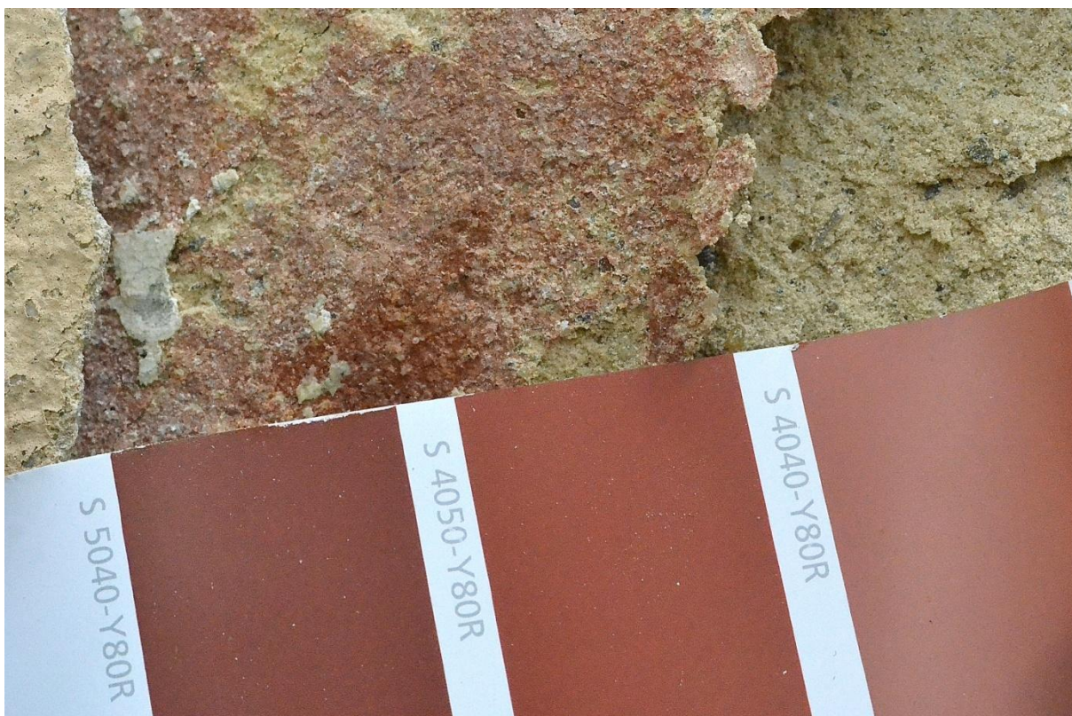
Odkrywka (2NCS) na północnej elewacji oranżerii. Dopasowanie do niej barwy z wzornika kolorów NCS. Najbardziej zbliżony jest nr S 4050-Y80R
