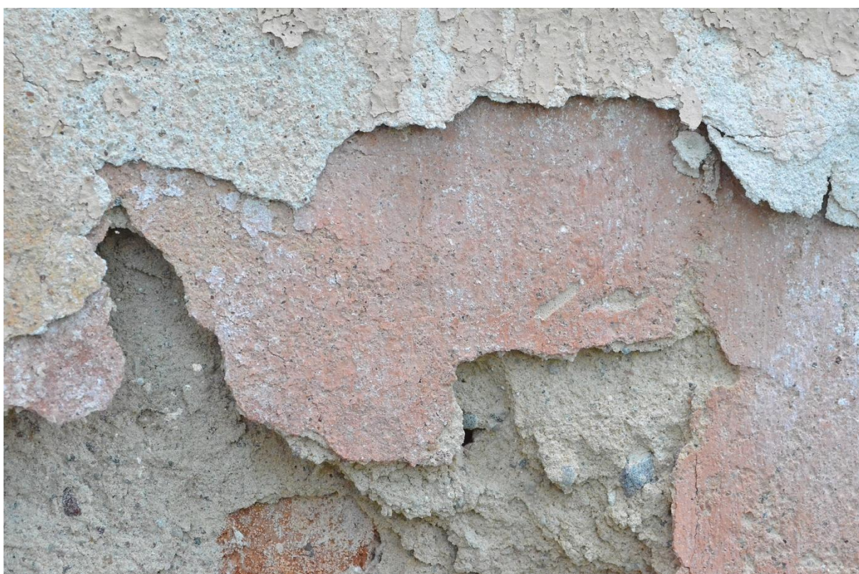
Odkrywka (2) na elewacji północnej oranżerii
