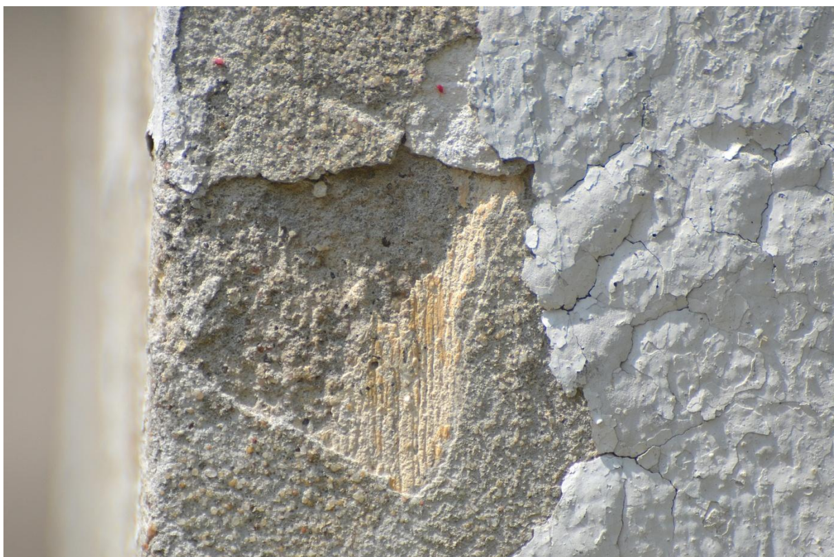
Odkrywka (1) na ścianie elewacji wschodniej
