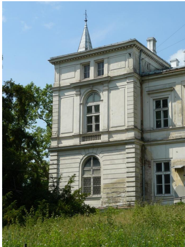
Pałac Kronenbergów w Więńcu, fragment elewacji wschodniej, fot. B.M. Gawęcka, 2016 r.
