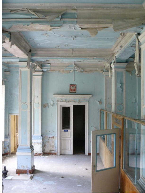
Pałac Kronenbergów, parter, hol, widok ze schodów, fot. B.M. Gawęcka
