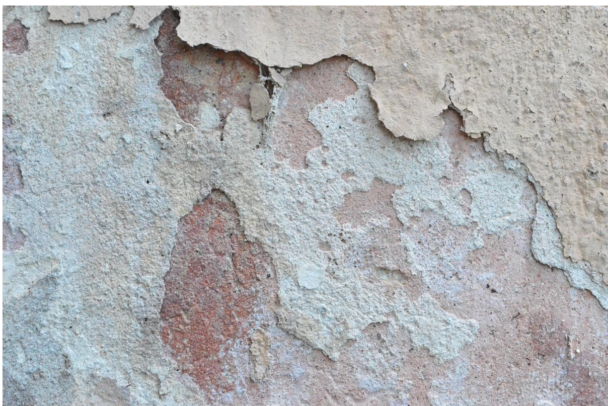
Odkrywka (4) na elewacji północnej oranżerii
