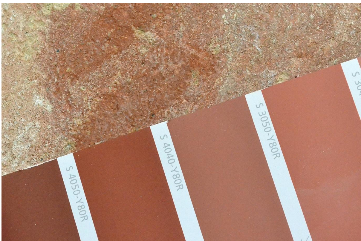
Odkrywka (3NCS) na północnej elewacji oranżerii. Dopasowanie do niej barwy z wzornika kolorów NCS. Najbardziej zbliżony jest nr S 4050-Y80R
