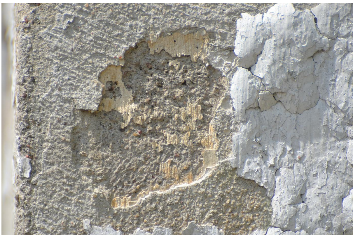
Odkrywka (2) na ścianie elewacji północnej
