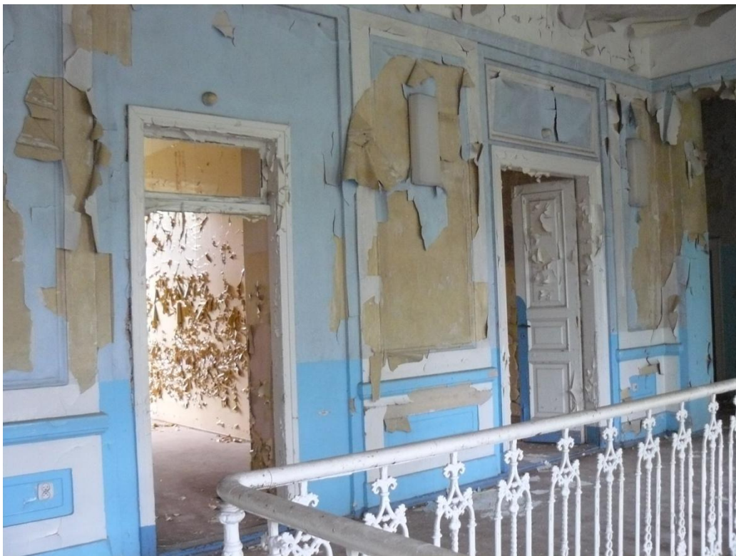
Pałac Kronenbergów, piętro, klatka schodowa, fot. B.M. Gawęcka
