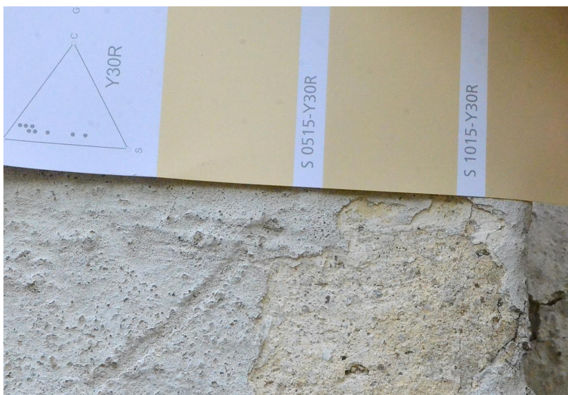
Odkrywka (1NCS) na ścianie elewacji wschodniej. Dopasowanie do niej barwy z wzornika kolorów NCS. Najbardziej zbliżony jest nr S1015-Y30R
