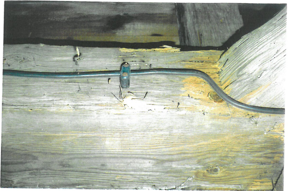
Fot. nr 16 Więżba porażona przez kolotka domowego.
