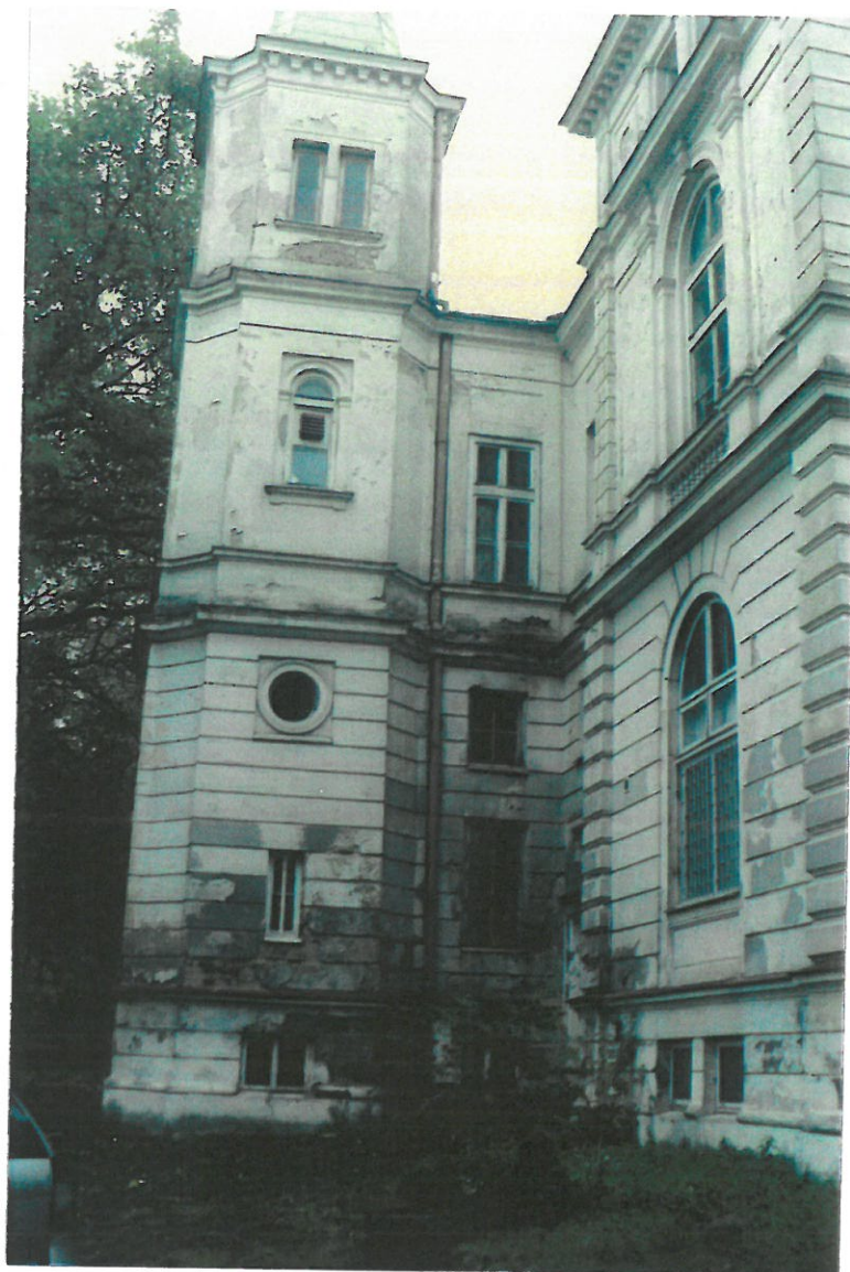
Fot. nr 3 Widok jednej z wież
