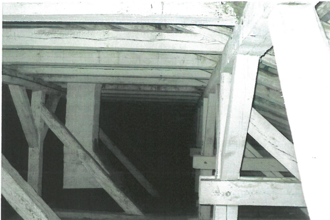
Fot. nr 12 Układ konstrukcyjny więźby dachowej.
