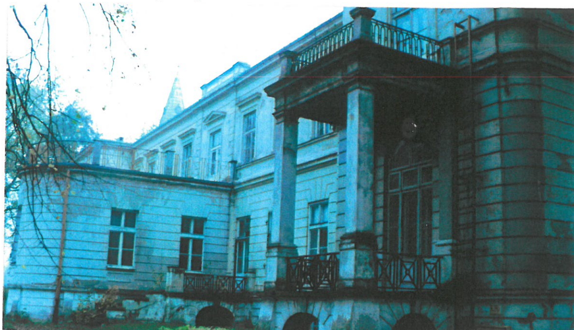
Fot. nr 4 Elewacja tylna z widoczną późniejszą przybudówką.
