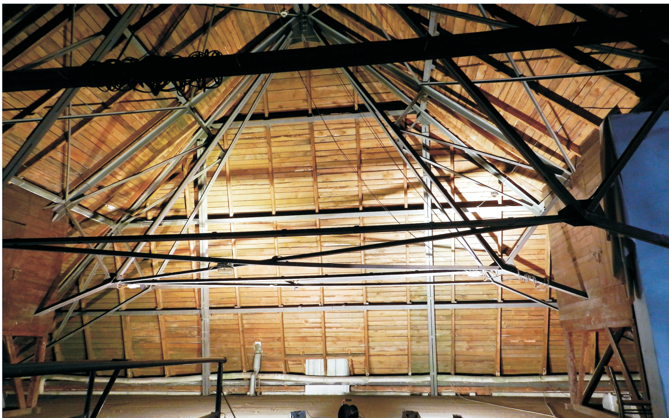
132. Poddasze budynku frontowego ze stalową więźbą współczesną. Widok w kierunku pd.. Fot. E. Nawrocka, 2013 r..
