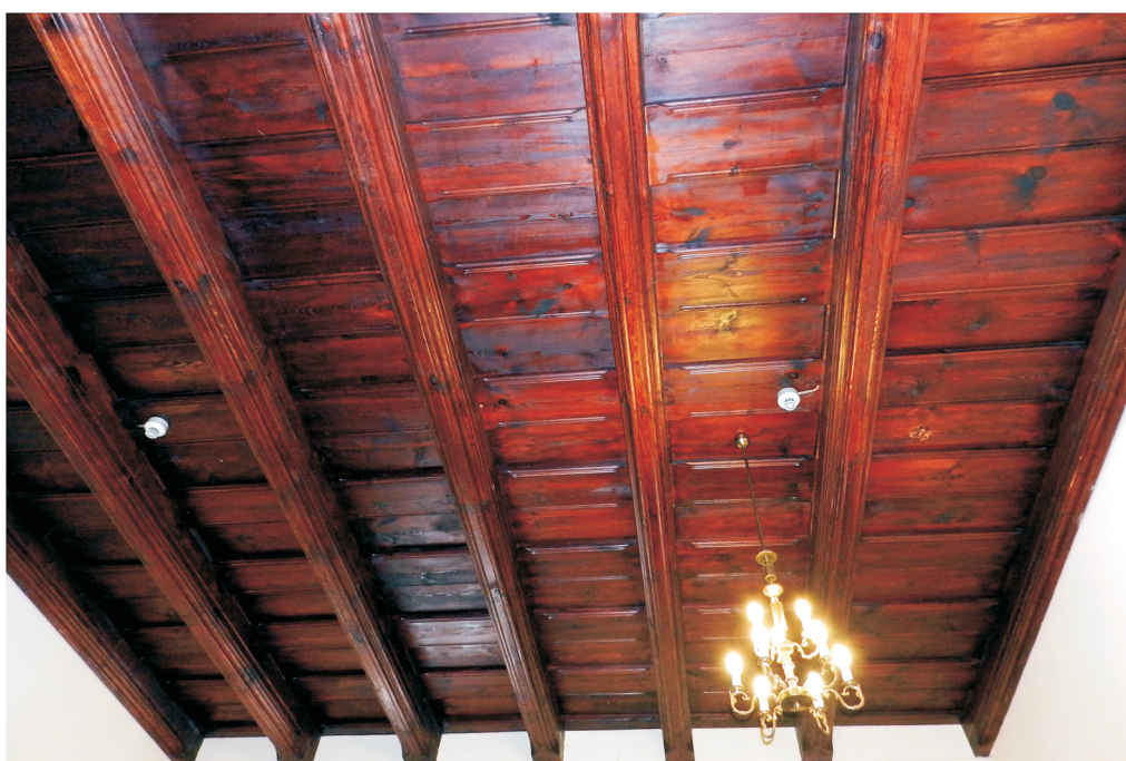
63. Parter. Hall w trakcie frontowym. Podwieszony strop belkowy. Widok w kierunku frontowym. Fot. E. Nawrocka, 2013 r..
