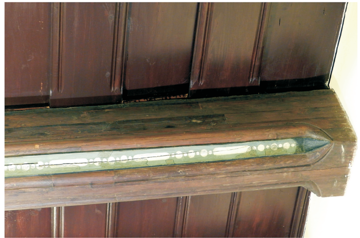
73. Parter, trakt tylny. Pomieszczenie 1.5. Zabytkowa belka stropowa z rekonstrukcją fragmentu polichromii. Fot. E. Nawrocka, 2013 r..
