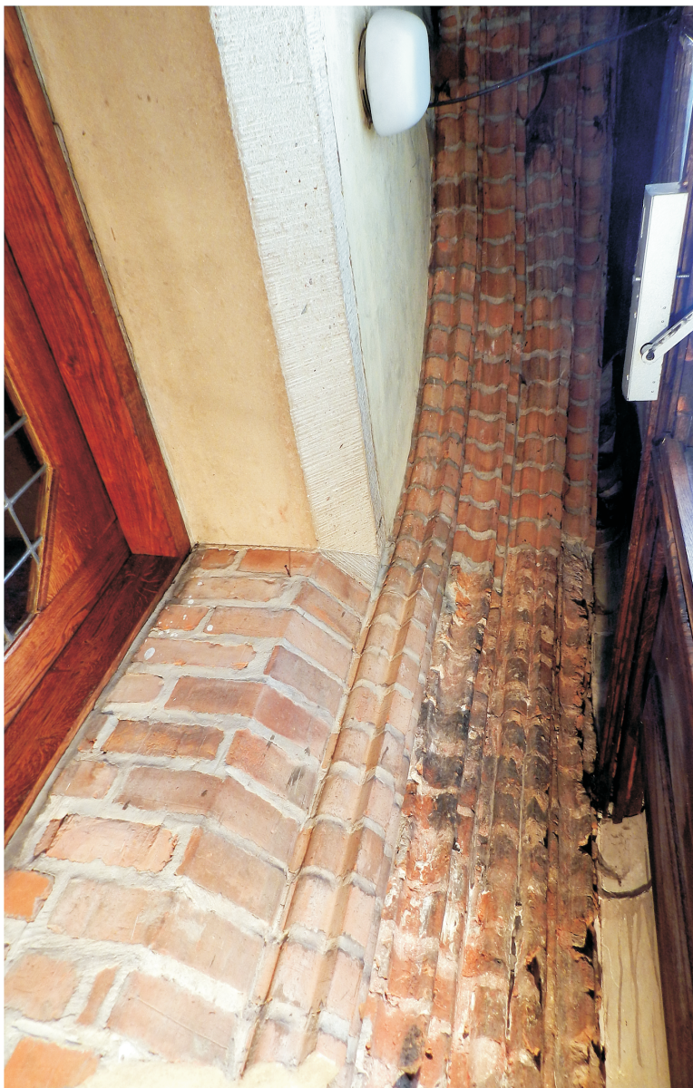
55. Parter. Wejście frontowe. Profilowane ostrołukowe zwieńczenie gotyckiego portalu. Widok od strony wejścia. Fot. E. Nawrocka, 2013 r..
