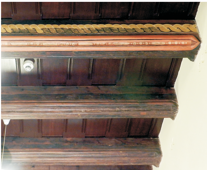
71. Parter, trakt tylny. Pomieszczenie 1.5. Fragment podwieszonego stropu z widoczną na belce polichromią odtworzoną na podstawie zachowanych śladów. Fot. E. Nawrocka, 2013 r..
