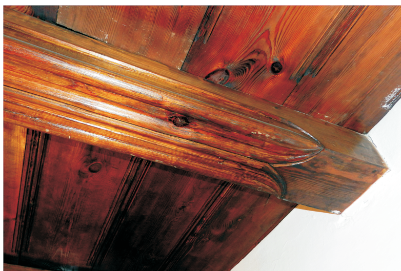
68. Parter, trakt frontowy. Pomieszczenie środkowe 1.2. Fragment podwieszonego stropu belkowego. Fot. E. Nawrocka, 2013 r..
