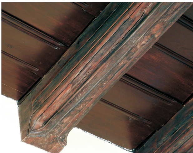
72. Parter, trakt tylny. Pomieszczenie 1.5. Fragment stropu z zabytkowymi belkami profilowanymi. Fot. E. Nawrocka, 2013 r..
