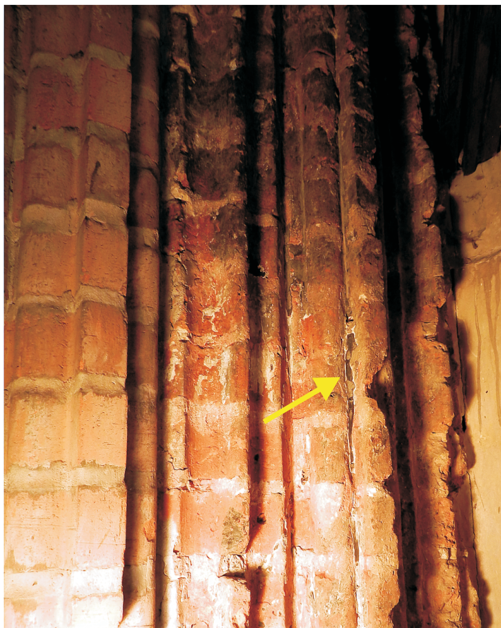
58. Fragment fot. 57. W załamaniach zachowane resztki dawnego tynku. Fot. E. Nawrocka, 2013 r..
