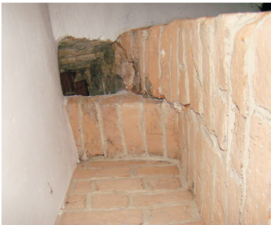
31. Piwnica. Pomieszczenie 0.8 traktu frontowego. Wnęka w murze pn.. Widok w górę na przewód kominowy. Fot. Z. Nawrocki, 2013 r..
