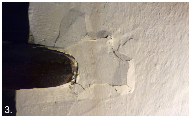
1. Ściana południowa w pomieszczeniu 1.5, dodana w XXw., pomalowana na czarno. 2.-3. Zniszczenia tynków.
