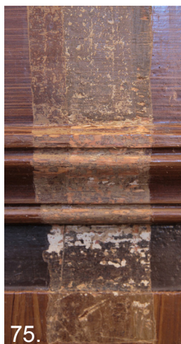
74.1. piętro, pomieszczenie 2.1, drzwi do pomieszczenia 2.4; 75.-76. Odkrywka stratygraficzna, oznaczone 4 fazy chronologiczne kolejnych warstw mazerunków (I–najstarsza, XIXw.?)
