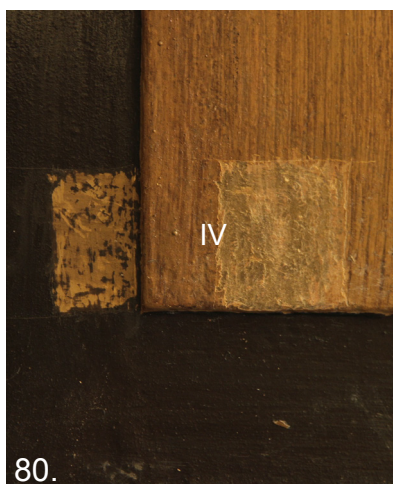
79. 1. piętro, pomieszczenie 2.1, drzwi do pomieszczenia 2.1 80. Odkrywka stratygraficzna, oznaczona ostatnia faza chronologiczna - tło mazerunku i wykończenie (wcześniejsze warstwy niezachowane)
