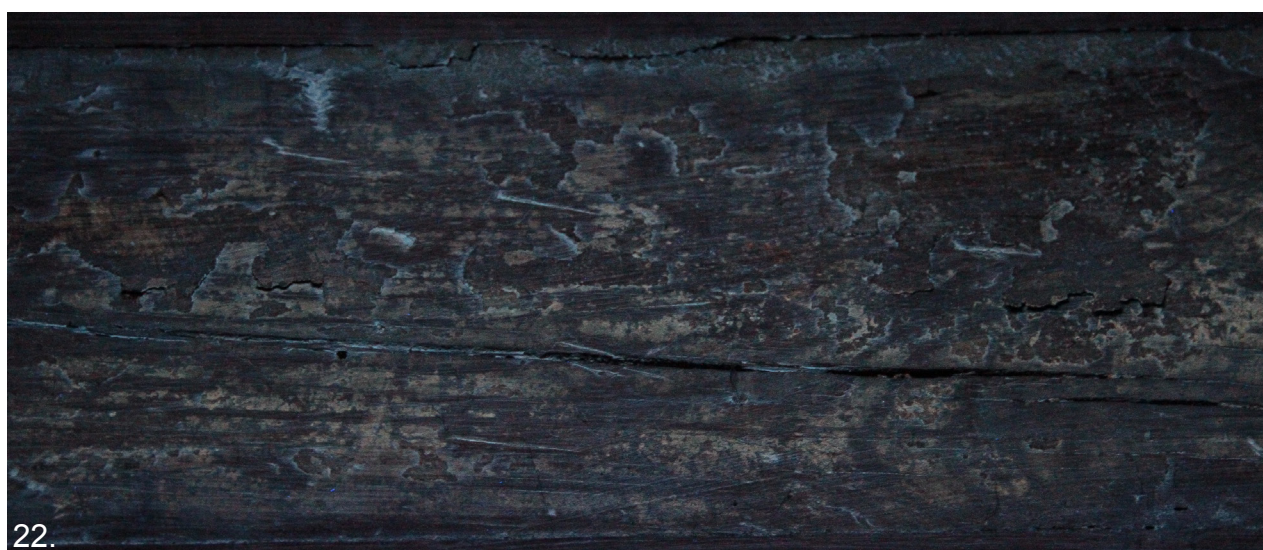
19. Nowa belka dodana podczas prac rekonstrukcyjnych stropu.
